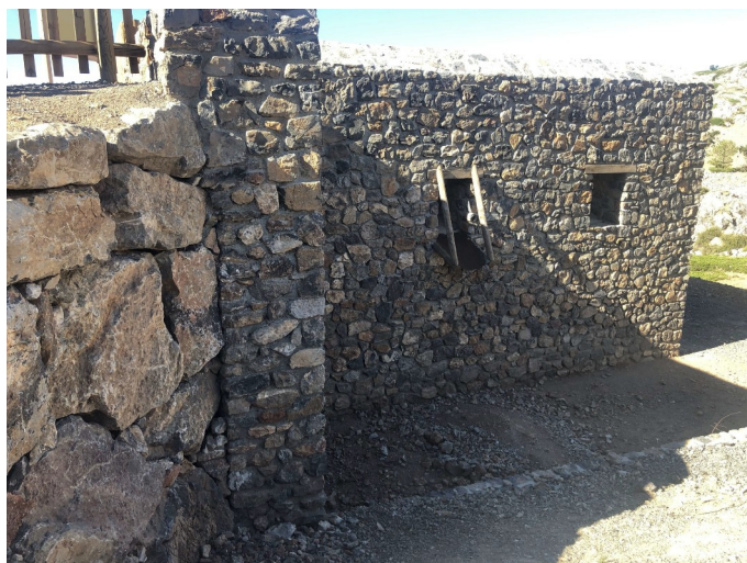
Tolve restaurada en Minas del Carmen
