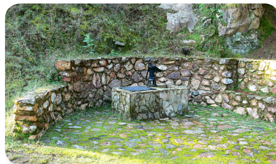
Fuente de Juan Díaz con una bomba manual para la extracción de agua
