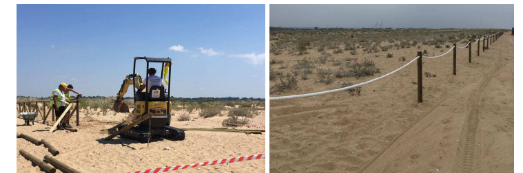
Prolongación e instalación de nuevos vallados (actuación complementaria)
