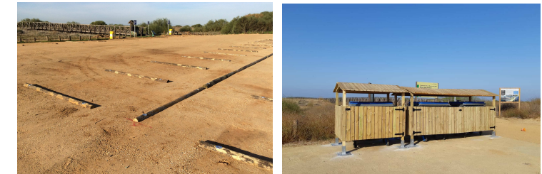
Adecuación de aparcamientos: adecuación de firme, instalación de balizas v cubre-contenedores
