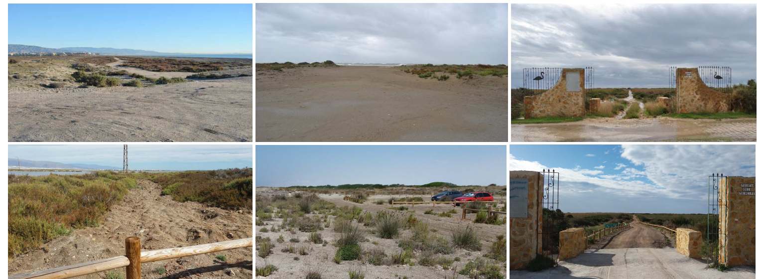
De izquierda a derecha, antes (arriba) y después (abajo) de: caminos interiores de circulación incontrolada de vehículos, cerrados mediante talanquera y roturados; espacios abiertos que daban acceso a la playa, delimitados mediante talanquera como bolsas de aparcamiento al final del vial; acceso de Percheles intransitable y tras la adecuación de firme y regulación de pluviales, para evitar la apertura de viales alternativos.
