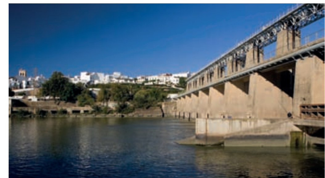
Vista lateral de las compuertas de la presa de Alcalá del Río. La permeabilización de esta estructura es esencial para la ictiofauna del Bajo Guadalquivir. Fotografía: Curro Cassillas
