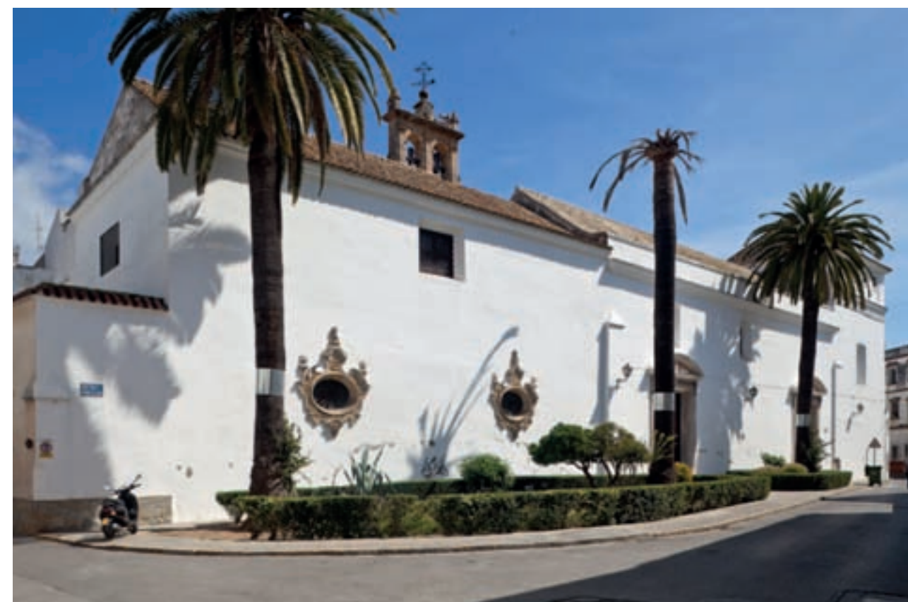
Fachada lateral del convento de Madre de Dios [siglos XVI-XVII] con sus portadas gemelas y ventanas ovaladas (XVIII), modelo de ida y vuelta para muchos edificios conventuales americanos. En la página de la derecha, fachada principal del mismo convento, obra singular y representativa del patrimonio monumental sanluqueño
