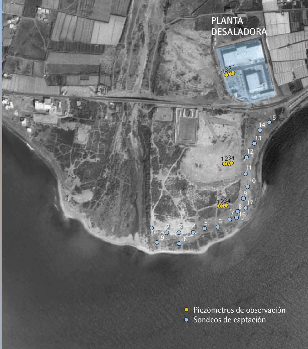
Instalaciones de la planta desaladora de Almería en el delta del río Andarax. Ortofoto: Junta de Andalucía.
