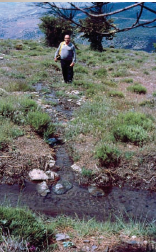
Arriba izquierda, piquera de la Acequia de Careo de Bayárcal en funcionamiento en el año 1985.
