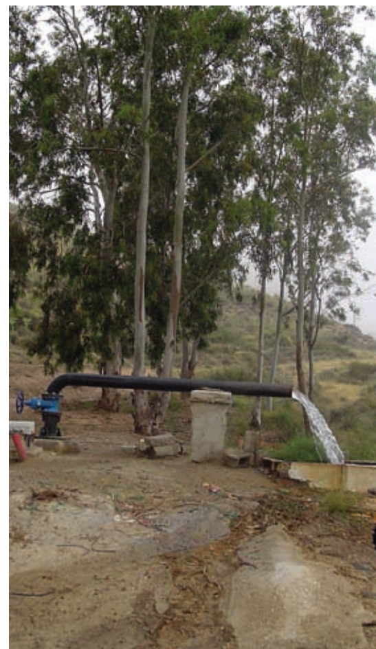
SONDEO EN EL ACUÍFERO CARBONATADO CON AGUAS TERMALES EN EL ÁREA DE BENAHADEX. FOTO: FRANCISCO SÁNCHEZ MARTOS.
