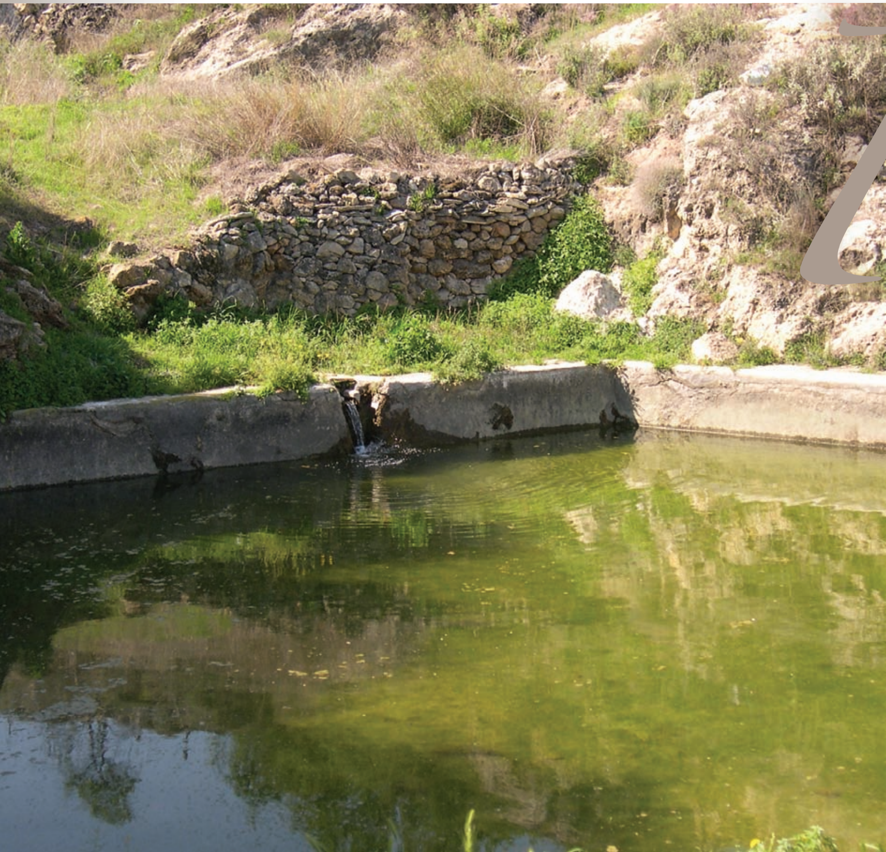
Esta balsa en las inmediaciones de Alhama de Almería ocupa el lugar de un bancal en una cañada (conjunto de balates laminando un cauce).
