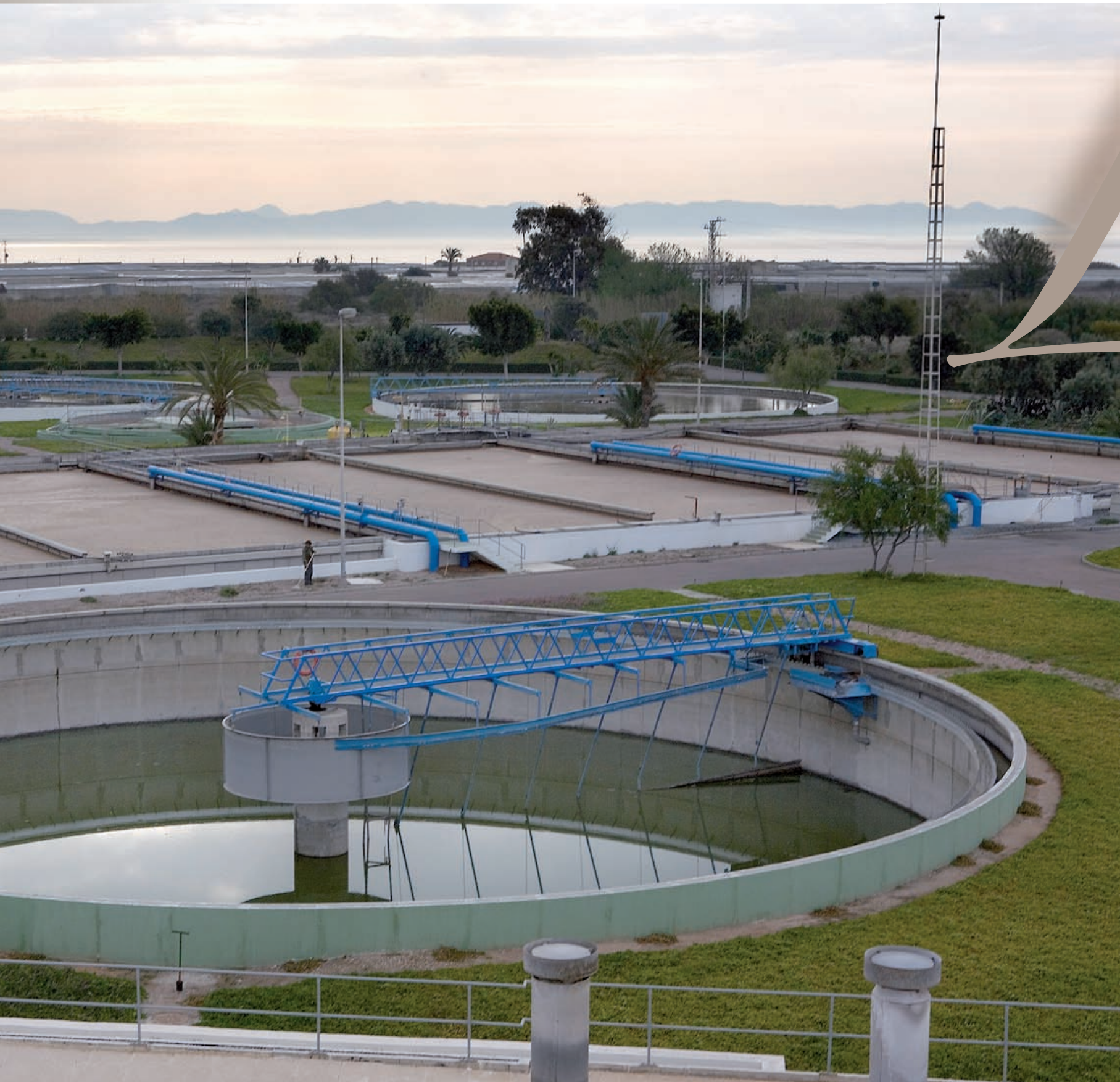
Estación Depuradora de Aguas Residuales (EDAR) El Bobar en Almería, cerca de la desembocadura del río Andarax. Foto: Luis de la Poza.
