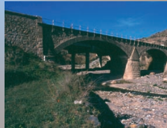
Arriba derecha, puente de los Calvos. Foto: Domingo Cuéllar Villar.
