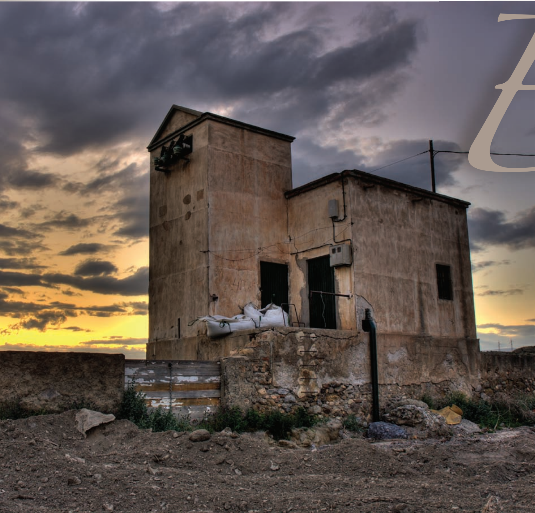
El pozo como servicio de suministro de agua. En el Andarax los pozos suelen estar dentro de una caseta cerrada, como éste en las proximidades del cauce del río en el municipio de Rioja.
