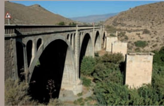
Angosturas de Galachar o Molino de los Imposibles. Vista de los dos puentes sobre el río Andarax de la carretera del Ricaveral. A la derecha, los estribos del puente metálico, a la izquierda, el viaducto de hormigón de la década de 1950. Foto: Enrique López Carrique.
