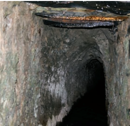
Arriba izquierda, interior de cimbra en Rágol.
