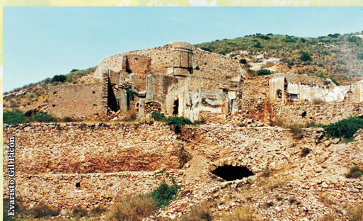
Ruinas de la planta de tratamiento que se instaló en la mina "María Josefa".
