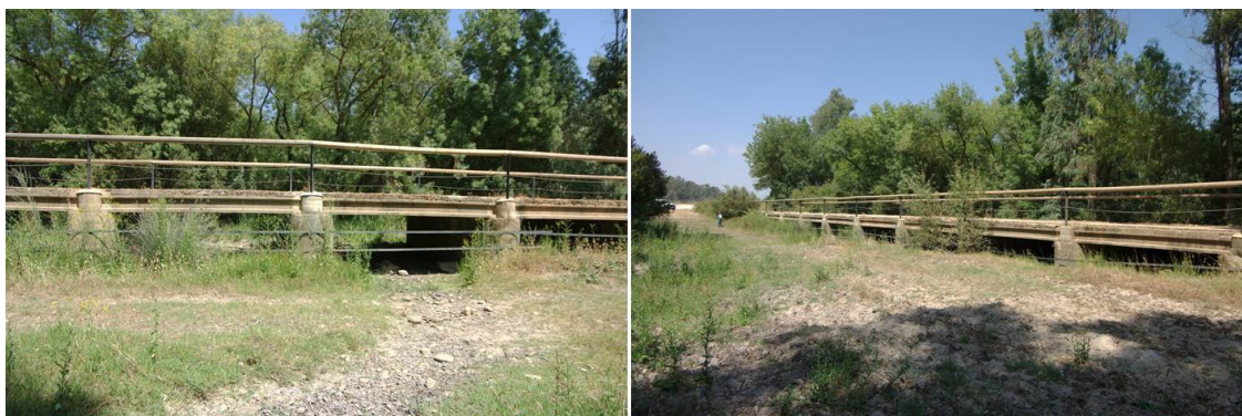
Figura 39. La Rocina II. Puente sobre el arroyo de la Rocina.
