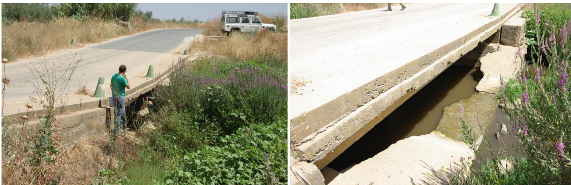
Figura 45. Arroyo del Gato. Puente sobre arroyo del Gato.
