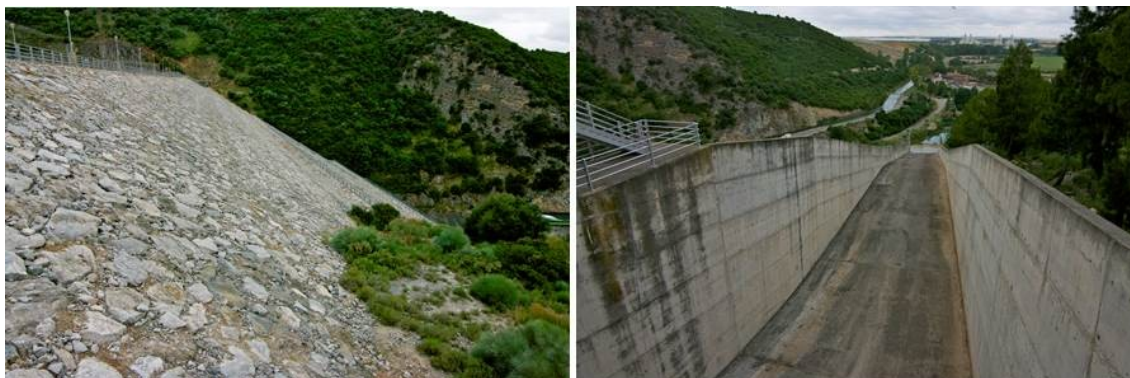
Figura 12. Presa (izquierda) y aliviadero (derecha) del Guadalcacín.
