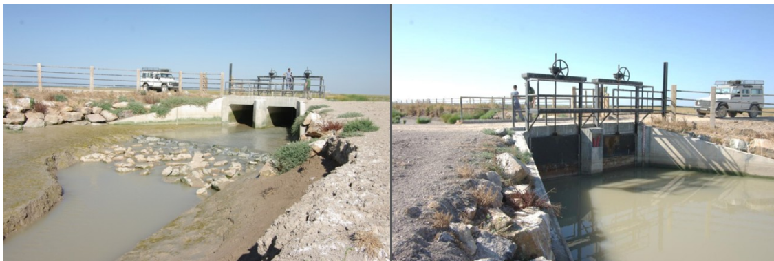
Figura 59. Compuertas sobre el caño de Brenes.
