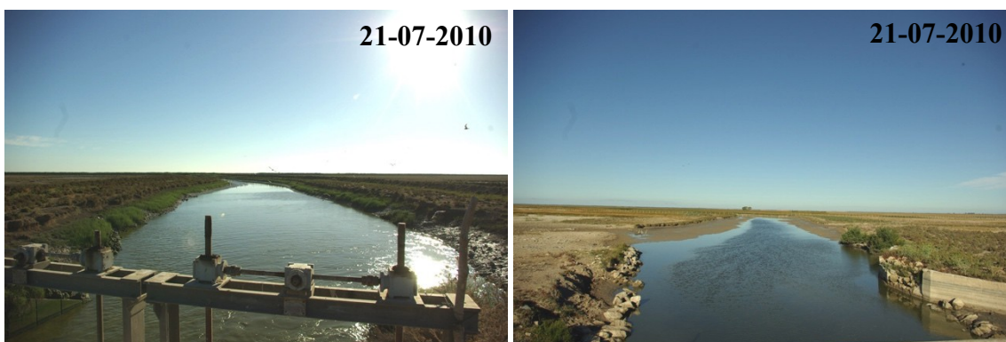
Figura 69. Estado del caño del Buen Tiro durante el muestreo de julio de 2010. La fotografía de la izquierda se tomó de la localidad situada de compuertas hacia fuera (CH01) donde el caño está completamente lleno con agua mareal y la fotografía de la derecha se tomó de compuertas hacia dentro (CH02), donde la compuerta impedía que la entrada libre del agua y de los organismos acuáticos.
