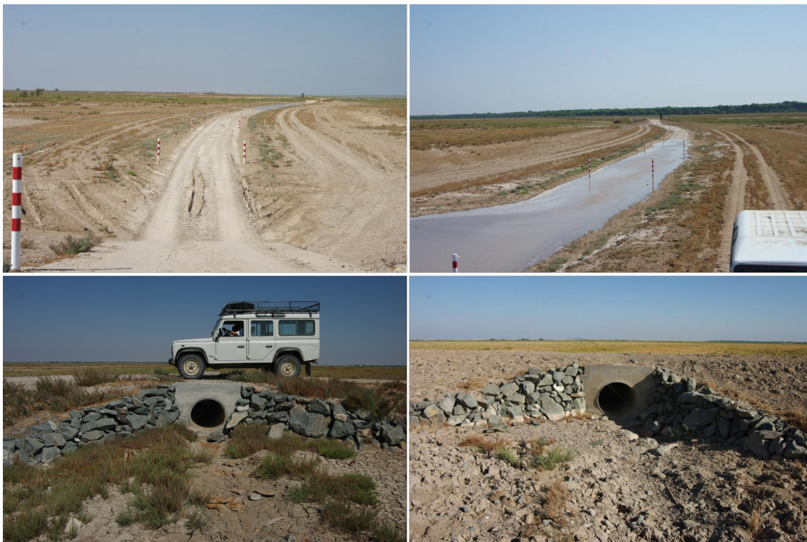
Figura 67. Obras de permeabilización en la Montaña del Río: vados (arriba) y tuberías (abajo).
