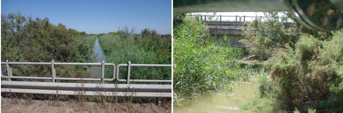
Figura 47. Entremuros I. Puente del Vado Simón.
