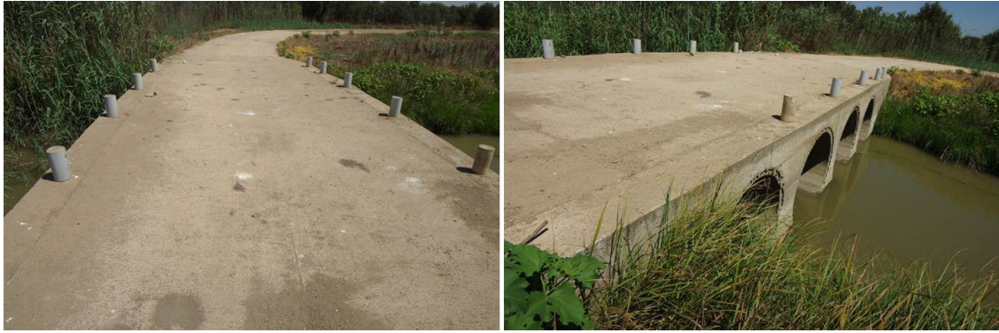
Figura 50. Entremuros IV. Vado sobre encauzamiento del Guadamar.
