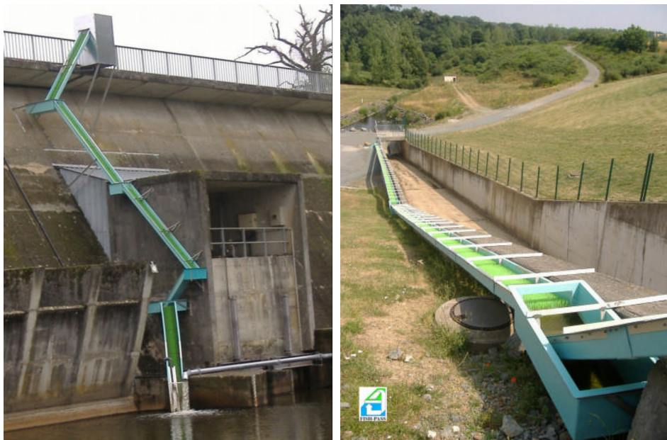
Figura 14. Disposición de la escala en presas verticales (izquierda) y en presas de tierra compacta (derecha) (Fotos: www.fish-pass.fi ).
