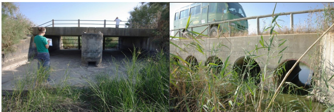
Figura 65. Puentes del camino del muro de la FAO sobre el caño Guadamar.
