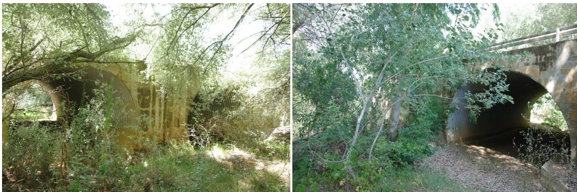
Figura 44. Arroyo de la Pilas. Puente sobre el arroyo de Pilas.
