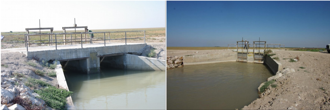
Figura 58. Compuertas sobre el caño del Figuerola (arriba) y escotadura realizada en la Montaña del Río (abajo).
