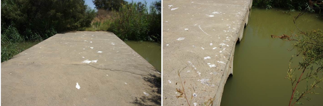
Figura 49. Entremuros III. Vado sobre encauzamiento del Guadiamar.
