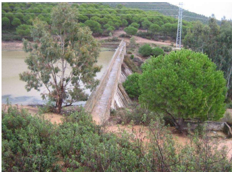
Figura 5.2.3 (3): Presa de Tres Picos
