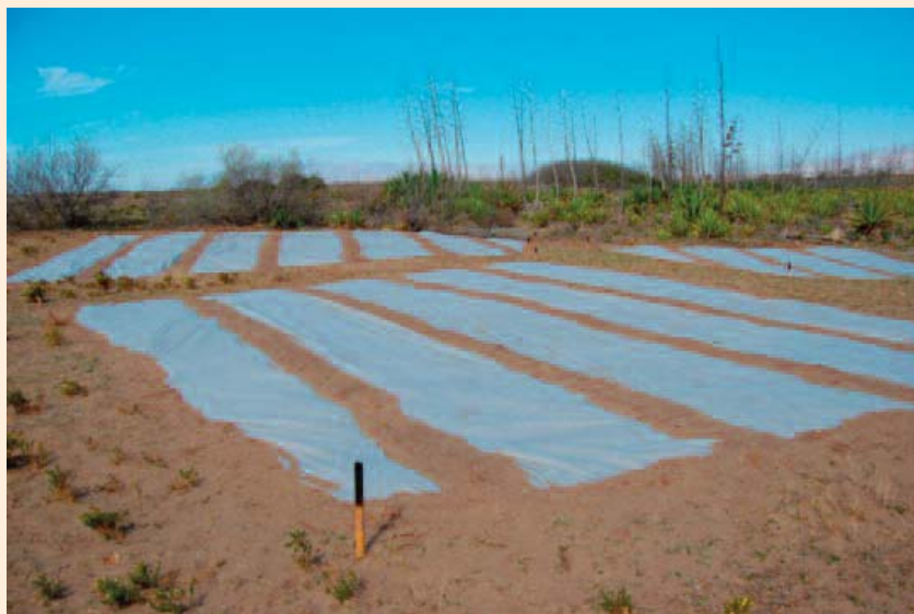
Fig. 19. Aspecto de la parcela con el geotextil, después de haber desbrozado los rodales aislados. Nótese que las tiras de geotextil se han solapado y cubierto de arena para protegerlas del viento.
