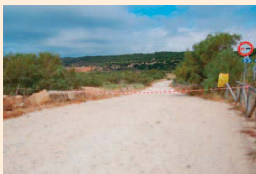
Fig. 10. Camino cerrado temporalmente al paso de vehículos y personas ajenos a la obra, junto a un cartel informativo sobre trabajos forestales.
