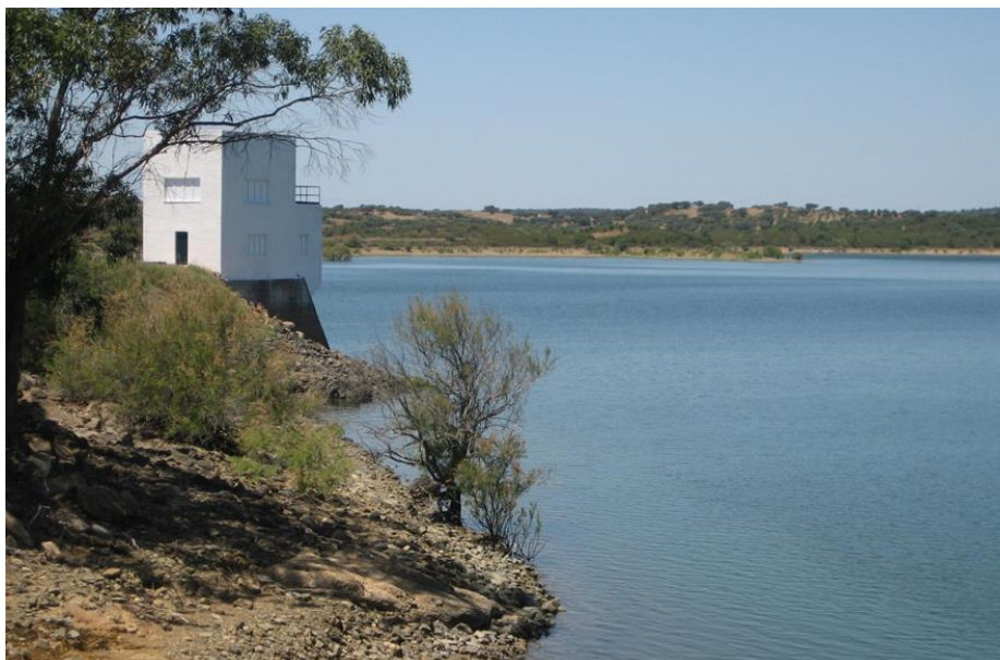
Figura nº 9. Presa del Piedras
