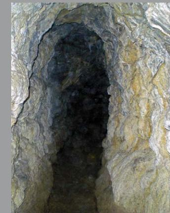
La construcción de galerías, a modo de minas, tenía por finalidad recoger gota a gota las aguas subterráneas que, canalizadas luego hacia albercas, facilitaban el riego de cultivos y el consumo humano.
