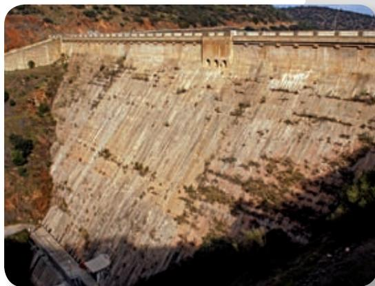
La presa del Rumblar, finalizada en 1941, tiene 65 metros de altura y una capacidad para 126 Hm<sup>3</sup> de agua embalsada, que se destina fundamentalmente para riego.
