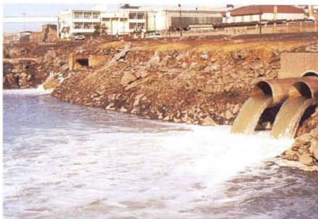
Los vertidos, residuos y desechos no sólo contribuyen a deteriorar el agua, el suelo y el paisaje, sino que suponen también un grave peligro. Fuente: Monteagudo, J., 1989.
