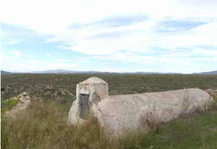
Aljibe de los Ventorrillos de Agua Amarga.
