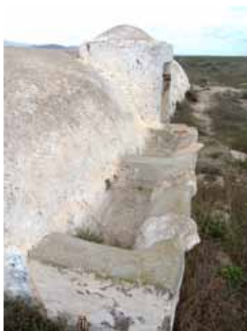
Aljibes del Ventorrillo de Agua Amarga.
