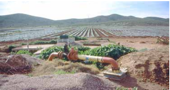
Sondeo de captación actual para uso agrícola en los cultivos de la finca Cortijo del Fraile.
