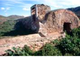
Aljibe principal del Cortijo del Fraile.
