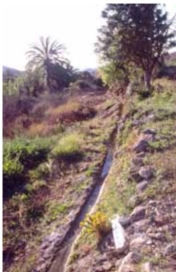
Los árabes introdujeron novedosas técnicas de captación y distribución de agua para uso agrícola. Algunas de las infraestructuras actuales se apoyan aún en las redes originales de distribución de esa época.
