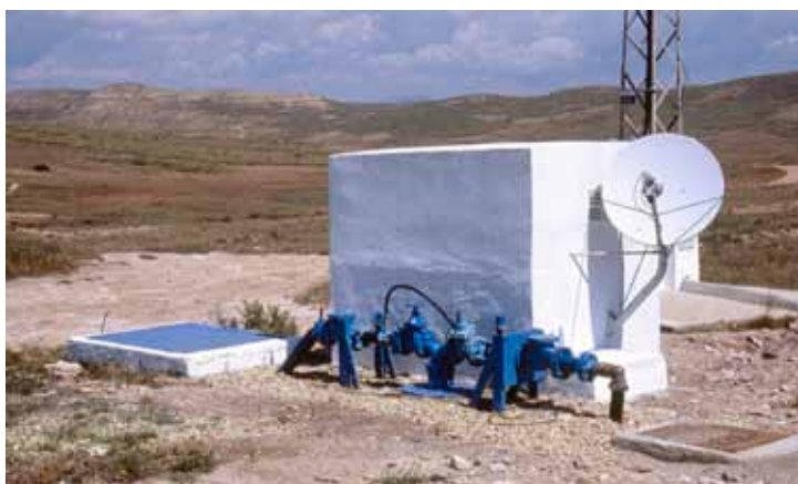
Sondeo de captación para abastecimiento a Fernán Pérez.
