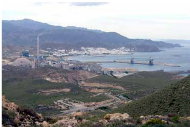
La desalinizadora de Carboneras se ubica en el polo industrial de esta localidad, junto a sus instalaciones portuarias.
