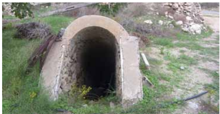
Entrada a la galería inclinada de acceso al pozo-noria.
