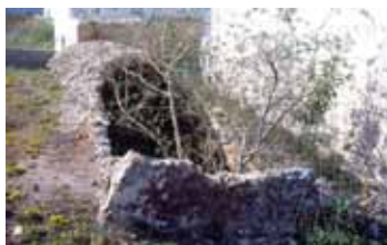
Restos del aljibe de la Fabriquilla.
