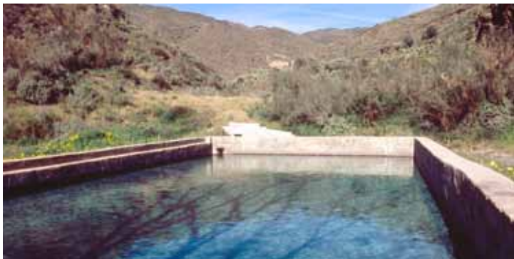
Balsa de acumulación y regulación para aprovechamiento de los caudales de pequeñas surgencias asociadas a los materiales metamórficos del entorno de la Cueva del Pájaro, en Sierra Cabrera.
