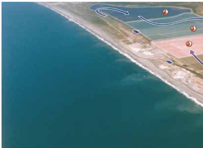
1 Canal alimentador de agua 2 Estanque evaporador
