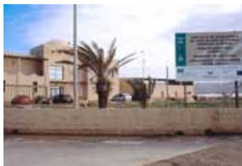
Desaladora de Cabo de Gata.
