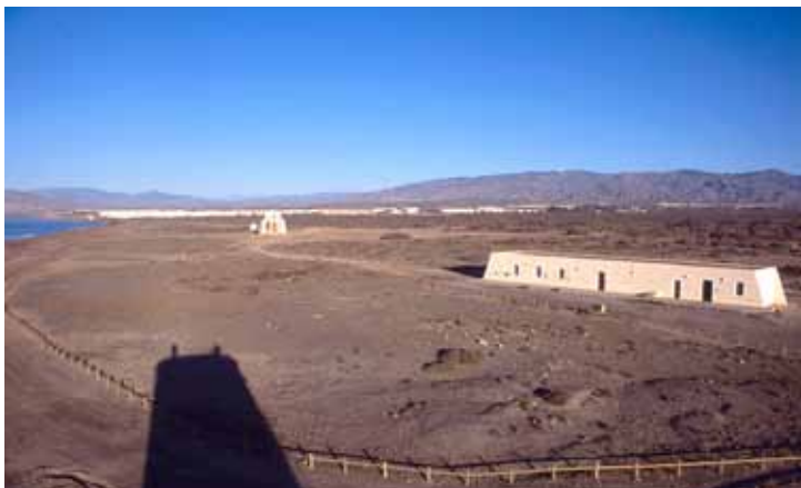
El antiguo cuartel de costa de la Guardia Civil acoge la Unidad de Interpretación de la Llanura Litoral de Almería; al fondo la ermita de Torregarcía, en primer lugar la sombra de la propia torre.
