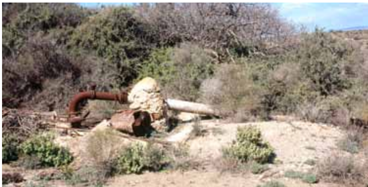
Sondeo de captación en desuso en Las Amoladeras.
