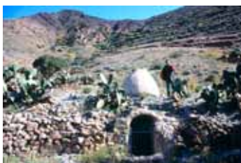
En las terrazas del tramo bajo del cauce, pequeñas obras de captación captan aún los recursos subterráneos del barranco.
