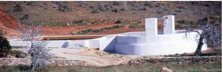
Los pozos-noria son los dispositivos históricamente más utilizados para posibilitar la captación de los recursos hídricos subterráneos de los pequeños acuíferos aluviales de rambla. En la foto dispositivo hidráulico de captación del pozo-noria de la rambla del Granadillo.
