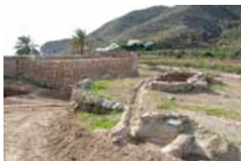
Noria y elementos hidráulicos auxiliares del Cortijo del Plomo.
