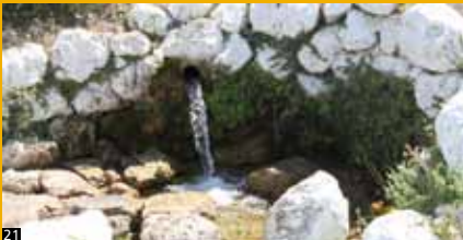
21 Pilar alargado perpendicular a la dirección del manantial
