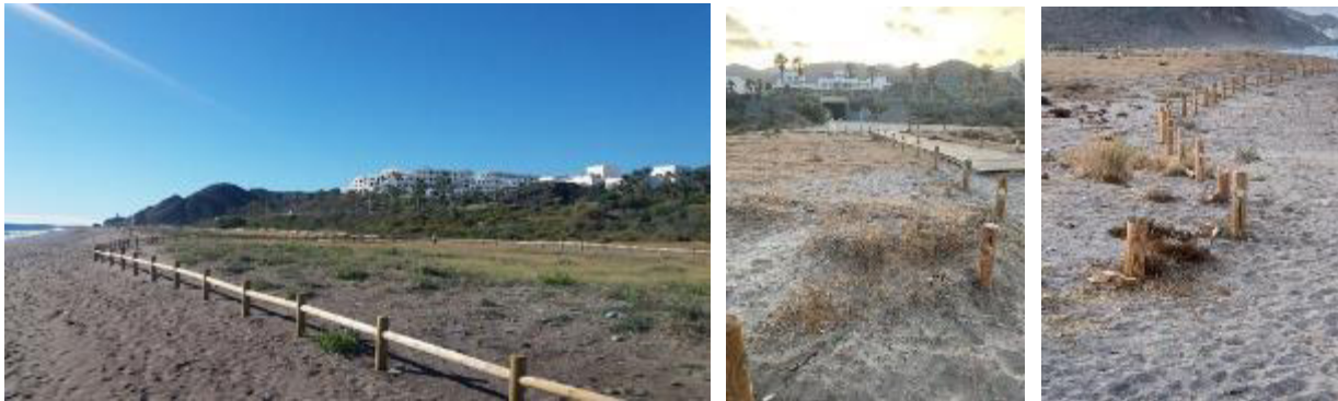
Fotos 15, 16 y 17. Talanquera instalada en playa Macenas (Mojácar. Almería) y mismo vallado, tras la sustracción de los rollizos superiores.
