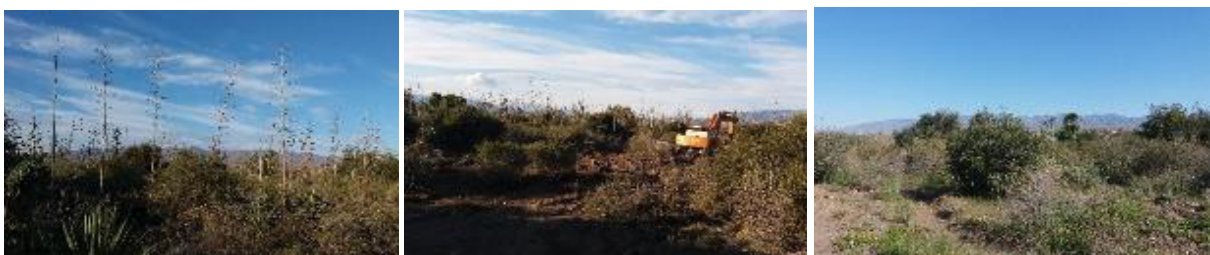
Fotos 29, 30 y 31. Antes y después de la eliminación de pitas ( Agave spp. ), por medios mecánicos, en la localidad de El Toyo (Ramblas de Gérgal, Tabernas y Sur de Sierra Alhamilla. Almería)
