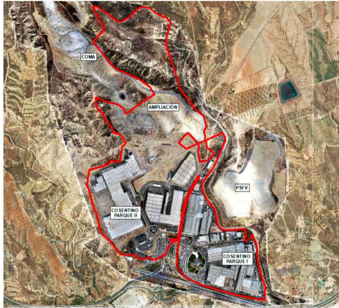
Figura 5. Instalaciones del Polígono Industrial Cosentino (Fuente Vis del promotor)
