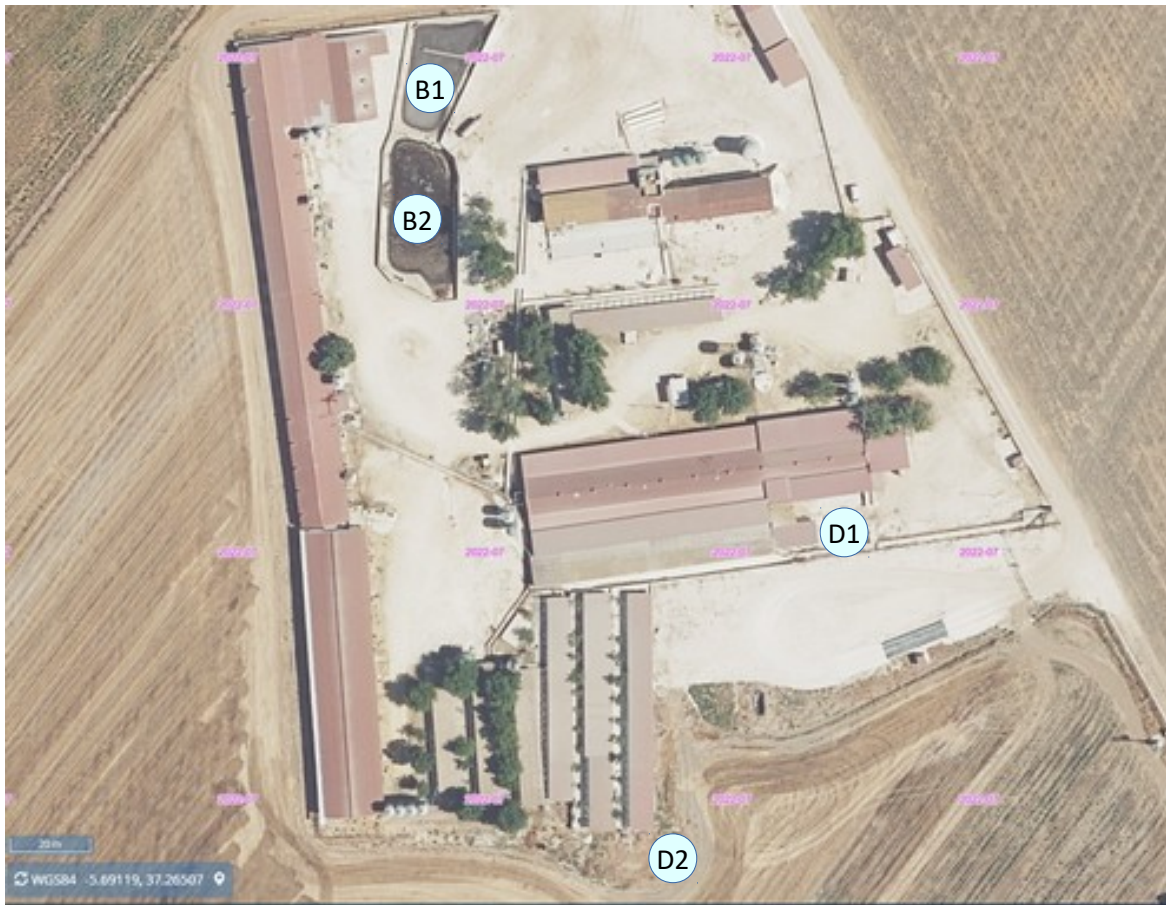
Sistema de almacenamiento de purines con el que cuenta actualmente el núcleo ganadero (formado por cuatro infraestructuras hidráulicas, de las cuales dos son balsas y las otras dos depósitos)
