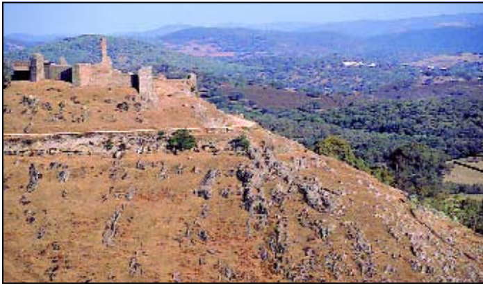
Restos de arquitectura defensiva.
