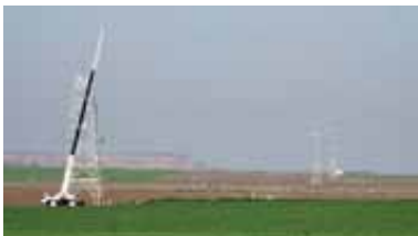
Instalación de tendido eléctrico
