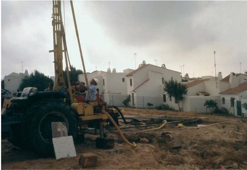
Perforación a rotación por circulación directa de un sondeo de reconocimiento y piezométrico en Matalascañas (Surfasaurus-Depuradora) en 1991 por un equipo del SGOP. Foto: EC.
