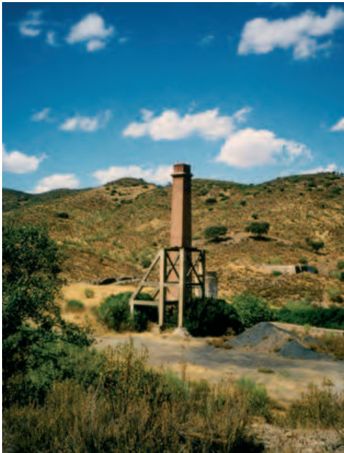
Restos del pozo y la chimenea del Pozo Maestro. J. C. Feixas Rodríguez.
