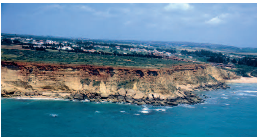
Panorámica del acantilado de Conil. Miguel Villalobos.
