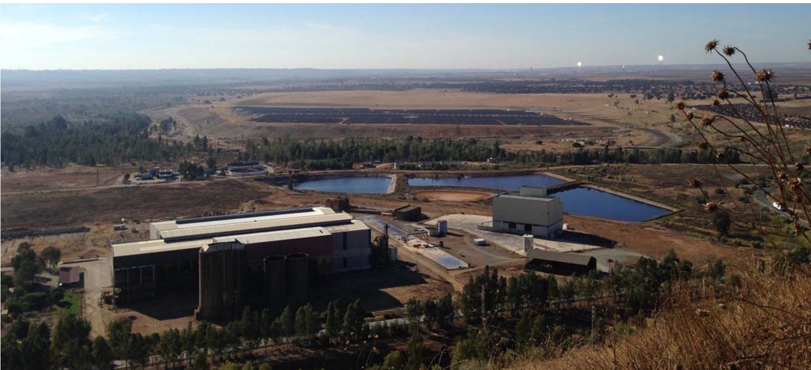
Fotografía 4: Vista de la antigua área industrial (Planta Mineralúrgico) y al fondo Presa de Residuos restaurada
