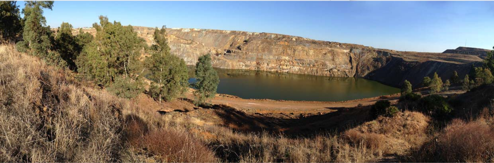
Fotografía 1: Vista de la Corta Aznalcóllar
