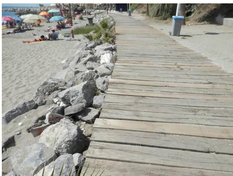
Foto A1.15. Pavimento de madera y talud de escollera para su sostenimiento
