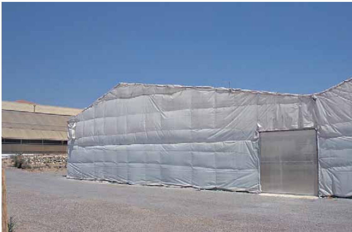
Foto 5. Invernadero de cubierta inclinada asimétrica
