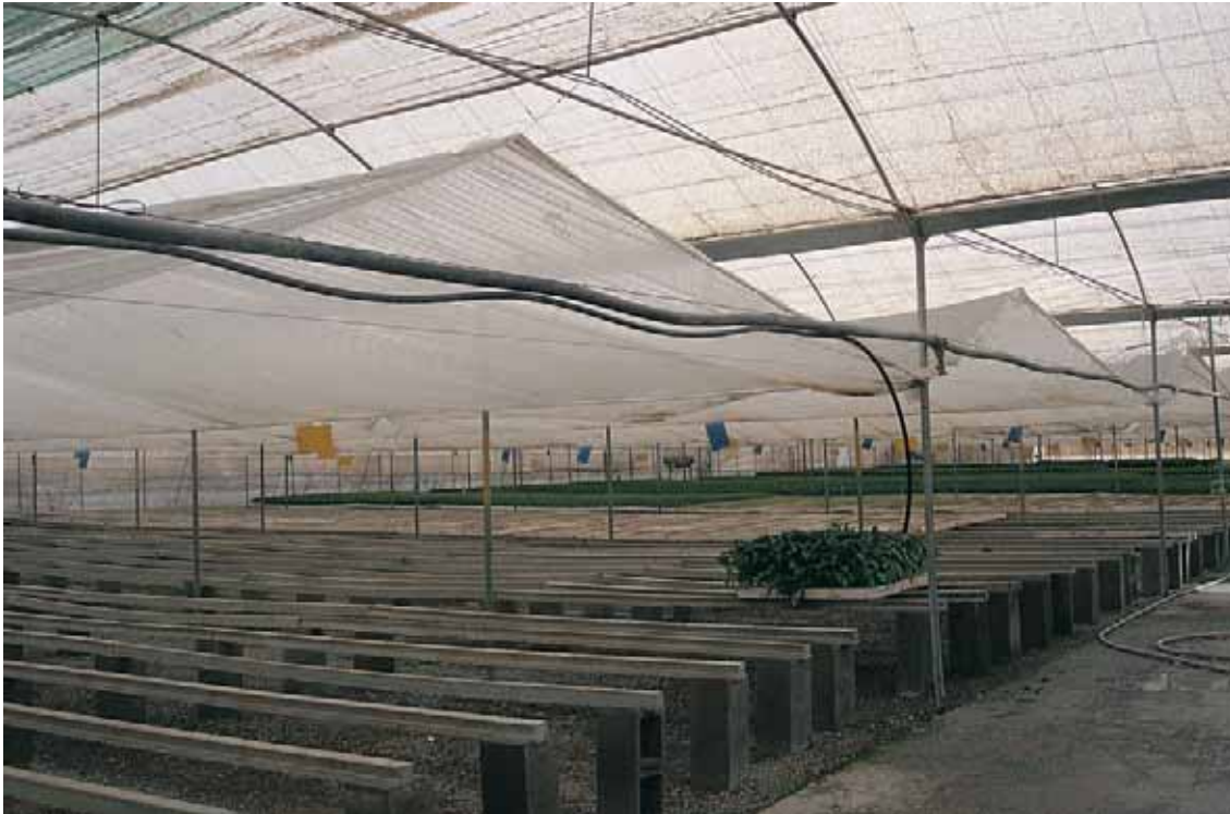
Foto 7. Colocación de un doble techo
