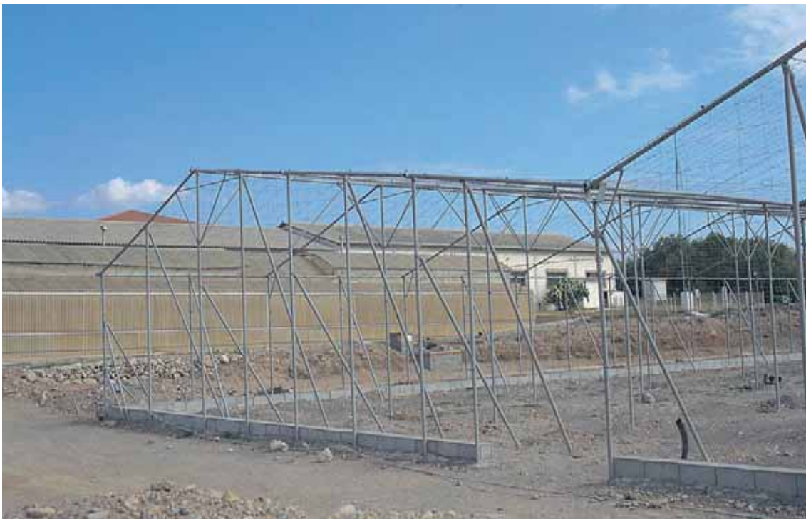
Foto 12. Estructura metálica de un invernadero de cubierta inclinada asimétrica
