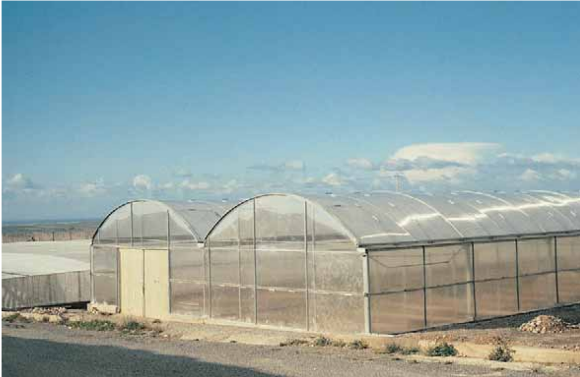
Foto 6. Invernadero de cubierta semicircular
