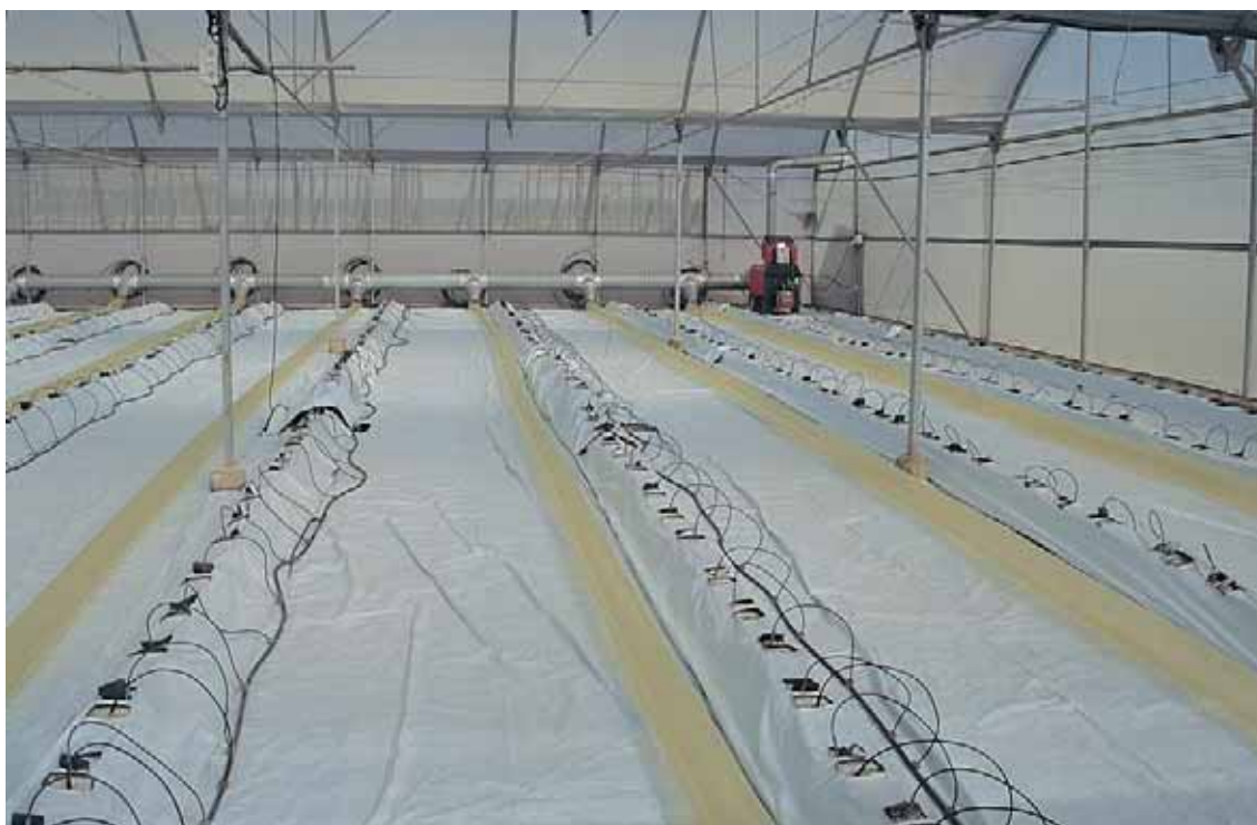
Foto 1. Colocación de sacos de perlita
