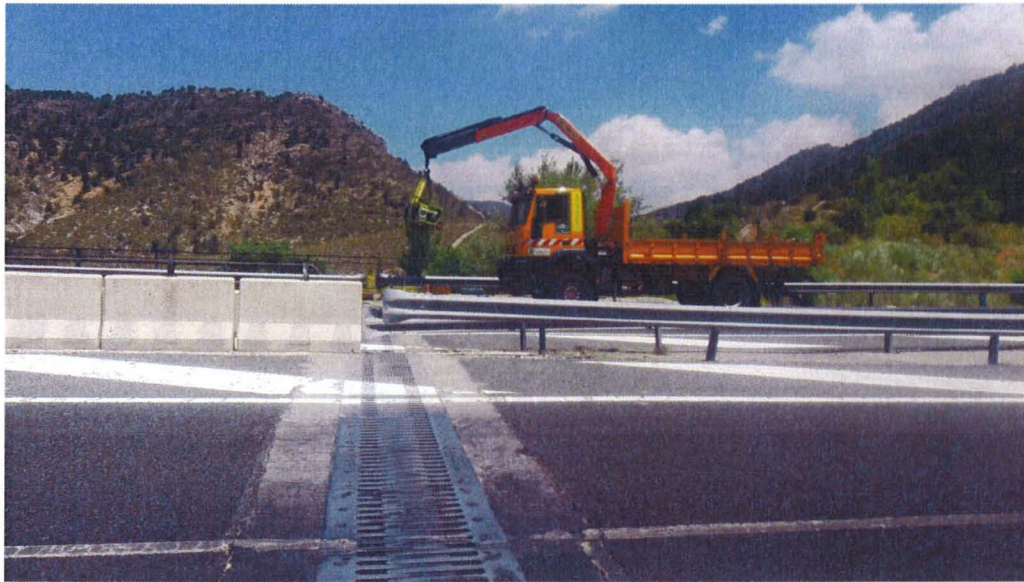
VISTA DE LAS JUNTAS DE DILATACIÓN. SE OBSERVA EL MAL ESTADO GENERAL
