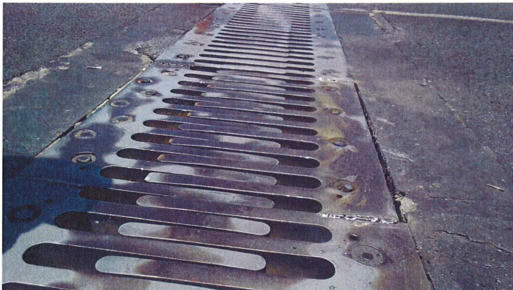
VISTA DE LAS JUNTAS DE DILATACIÓN. SE OBSERVA EL MAL ESTADO GENERAL
