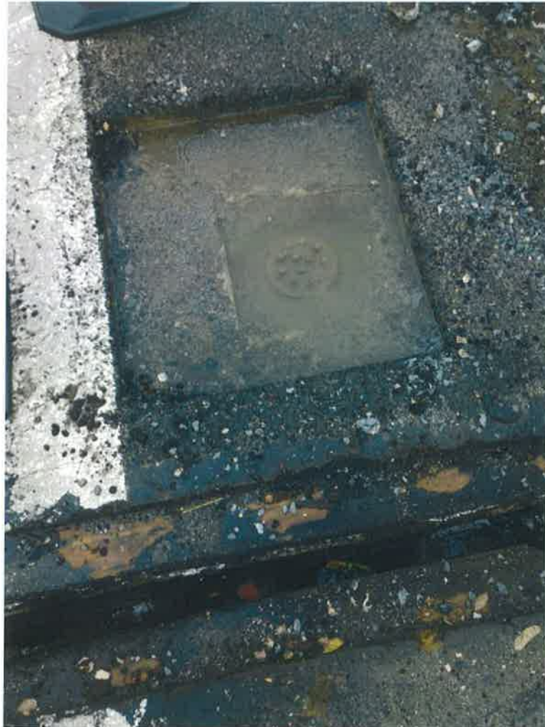
Cabeza del anclaje en superficie
