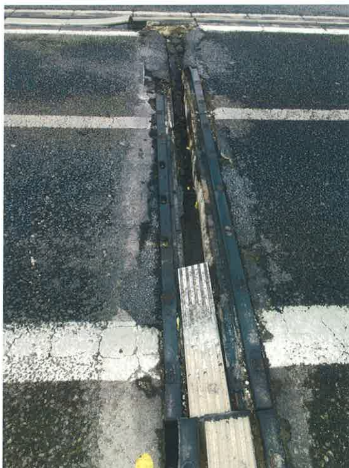
Junta transversal del estribo Oeste
