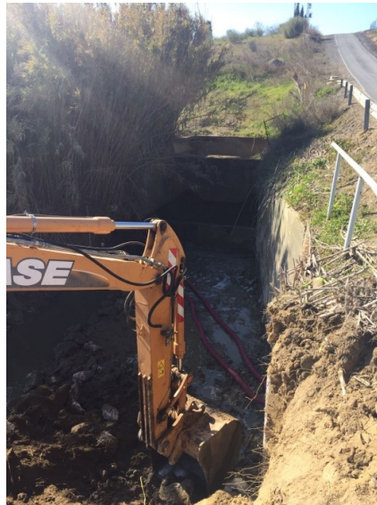
Operación de limpieza de desagüe dren transversal en Sifón N° 6. Al fondo se puede ver la obra de fábrica de los desagües de los elementos de regulación del Sifón.
