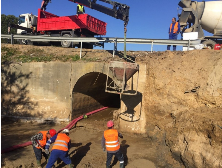
hormigonado de la solera de limpieza aguas abajo del Drenaje transversal en Sifón N° 6
