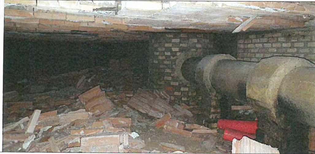
Foto 4 detalle de la conducción de saneamiento.
