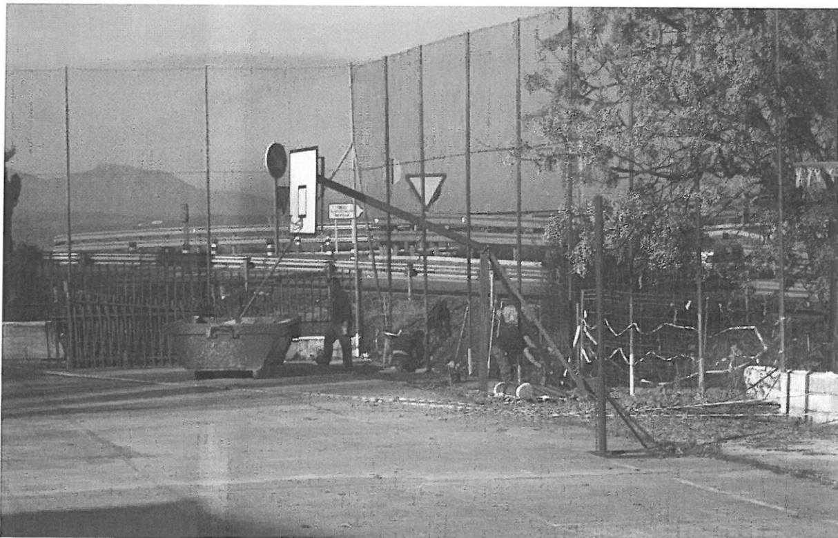
VISTA INTERIOR DEL TRAMO DE MURO AFECTADO
