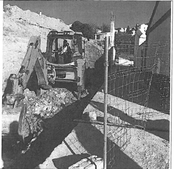
Foto 15. Se comienza con la excavación de la cimentación.
