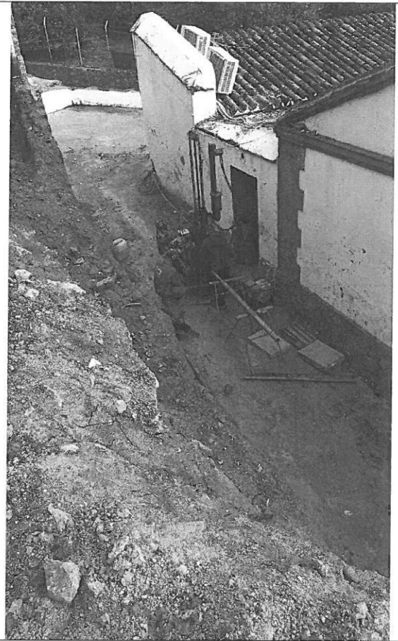
Foto 11. Se realiza toma de muestras y ensayo geotécnico.
