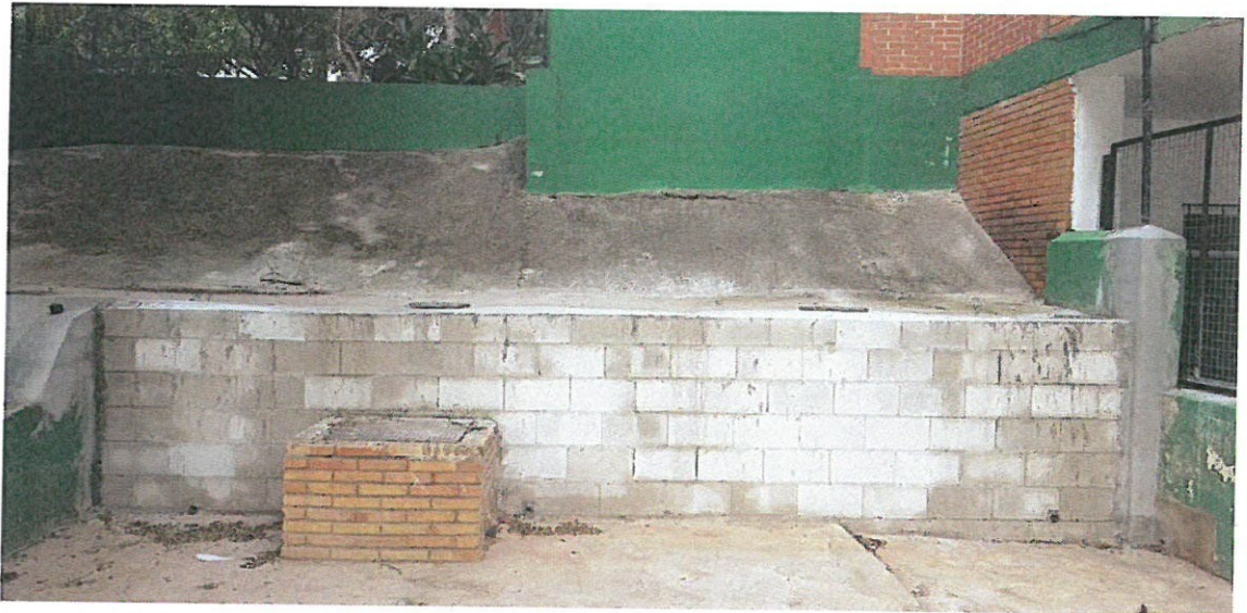
MURO DE BLOQUES DE HORMIGÓN
