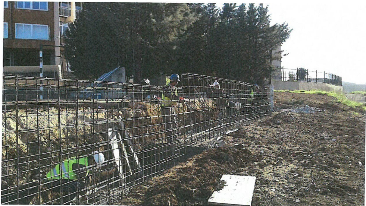
Ejecución de muro de contención de tierras de hormigón armado
