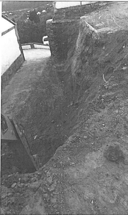
Foto 12. Se comienza con la excavación de la zona de actuación para la ejecución del
