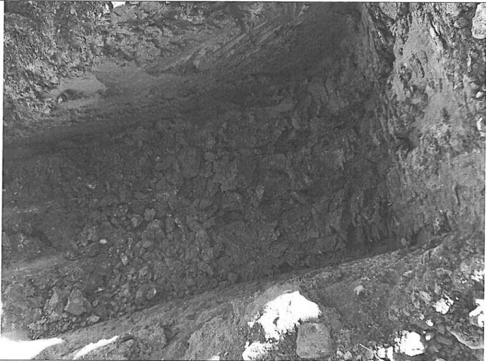
Foto 16. Se comprueba la cota de la cimentación con los datos del estudio geotécnico.
