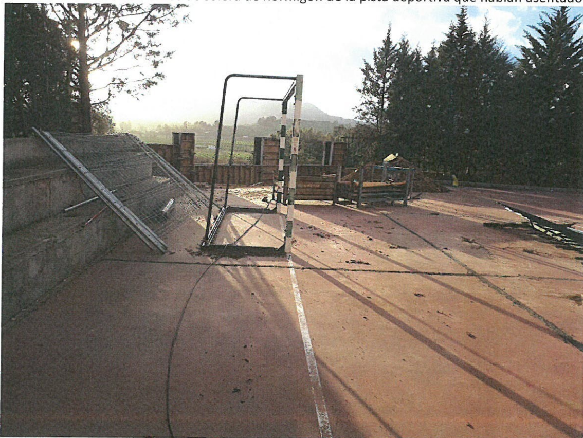
Reparaciones de juntas entre tramos de soleras de hormigón de la pista deportiva
