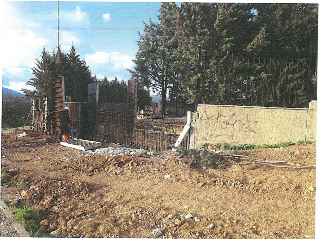
Ejecución de muro de contención de tierras de hormigón armado
