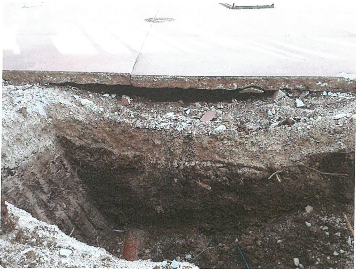
Demolición de tramos de solera de hormigón de la pista deportiva que habían asentado
