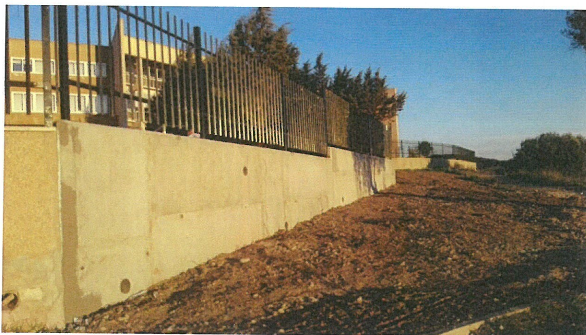
Ejecución de muro de contención de tierras de hormigón armado
