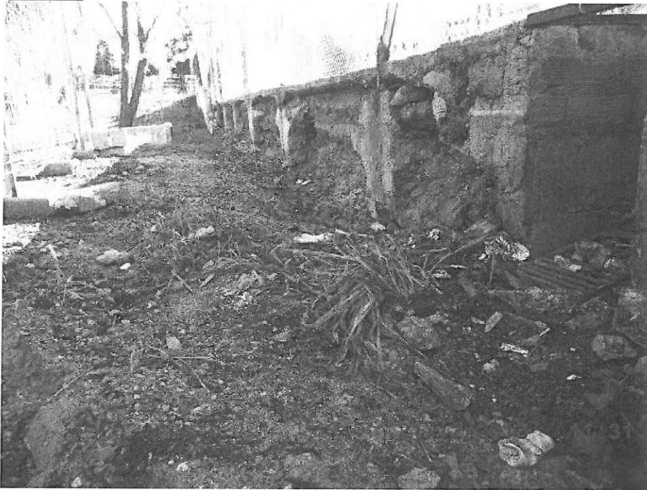
Limpeza de escombros de la zona exterior
