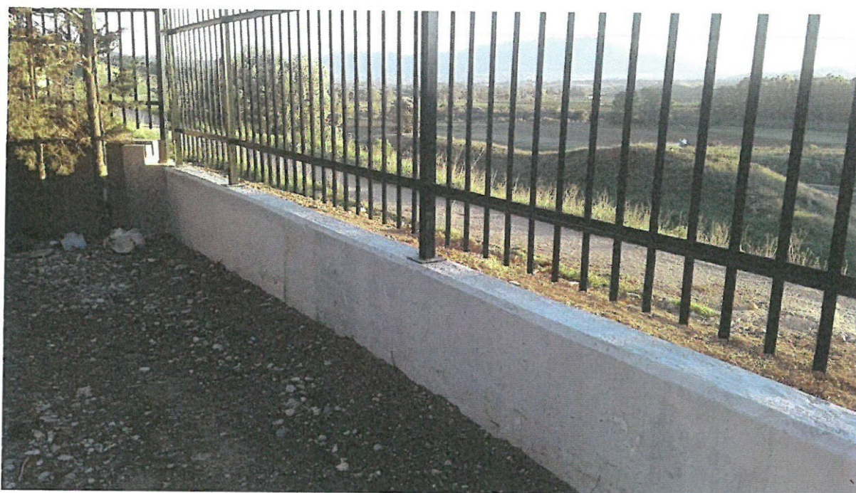
Ejecución de muro de contención de tierras de hormigón armado
