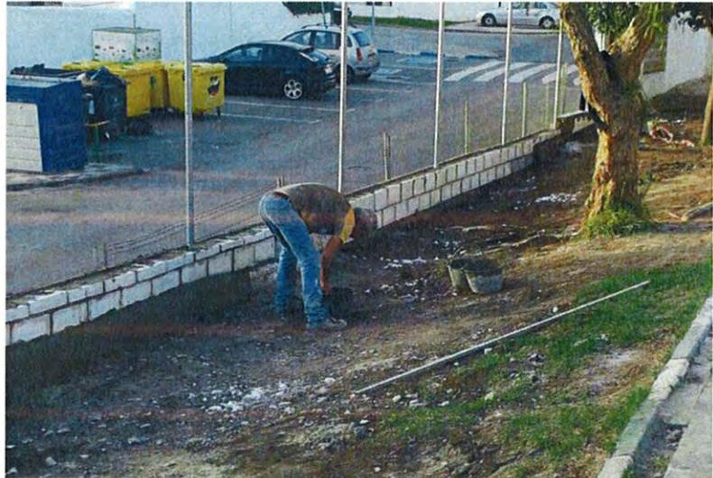
Los mástiles se han dispuesto cada 3.00m de longitud para asegurar la fijación de la malla de alambre de acero de simple torsión.
