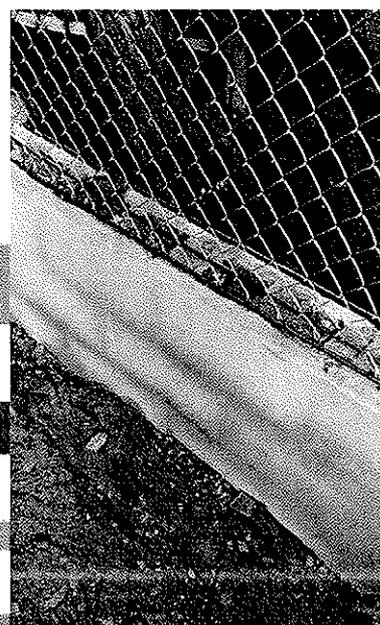
Una vez ejecutado el recrecido de los muros se revisten por ambas cara con una capa de enfoscado de mortero para su posterior pintado. Los mástiles se van dispuesto cada 2.50-3.00m de longitud para asegurar la fijación de la malla de alambre de acero de simple torsión.
