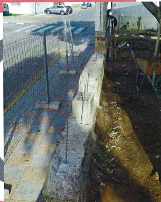
Una vez ejecutado el recrecido del muro se reviste por ambas cara con una capa de enfoscado de mortero para su posterior pintado.
