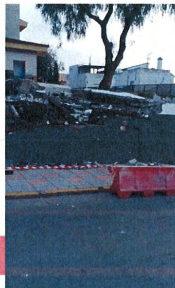
Una vez acabado los trabajos de desescombros, se coloca el vallado perimetral de la zona afectada y sobre la cual se va a trabajar. Para ello se instala una valla formada por piedras de apoyo prefabricadas de hormigón y tramos de malla de alambre de acero galvanizado, tipo Hércules.
