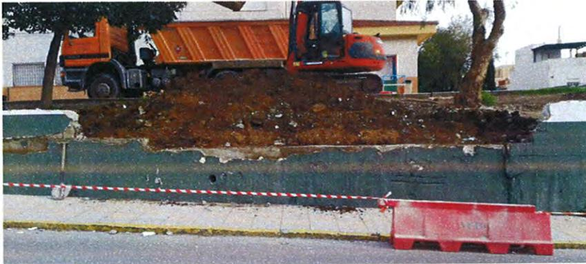
Las demoliciones se realizan con medios mecánicos, al igual que el desbroce y limpieza del terreno interior.
