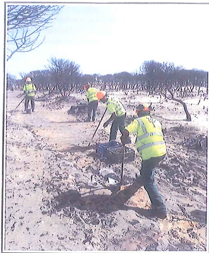
Imagen nº2 . Limpieza y acondicionamiento zona de la pasarela.
