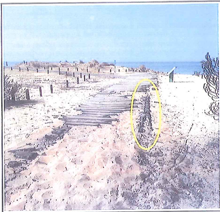
Imagen nº1. Estado de la pasarela de acceso tras el incendio. Detalle de elementos punzantes.
