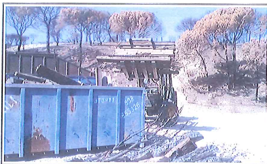
Imagen nº3. Retirada de residuos de la pasarela.
