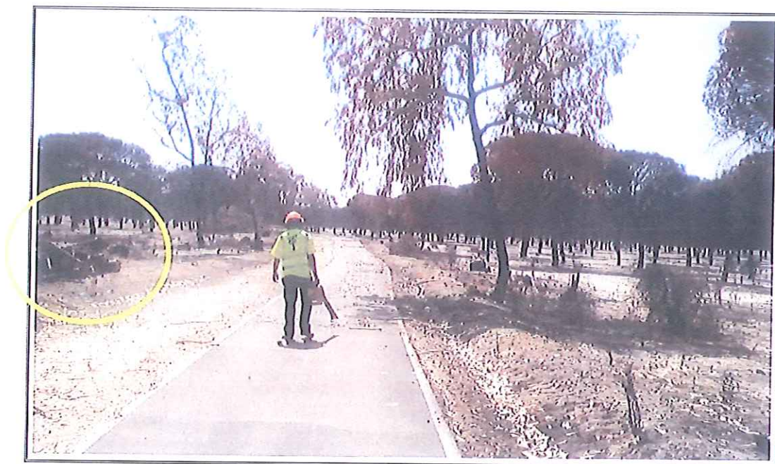
Imagen nº6. Limpieza y acondicionamiento del carril cicloturista. Detalle de acopio de madera de árboles apeados para su retirada.
