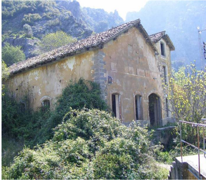
Central Hidroeléctrica de Valdepeñas de Jaén
