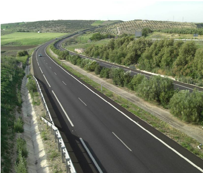
Autovía A-44 Bailén-Motril
