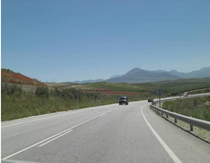
Carretera A-316 (tramo Puente del Obispo-Mancha Real), futura autovía del Olivar
