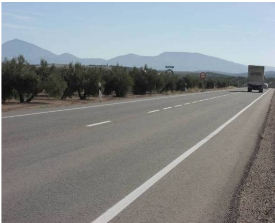
Carretera A-306 (El Carpio-intersección con la A-316 en Torredonjimeno), con previsión de desdoblamiento
