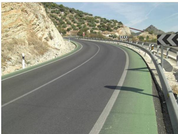
Carretera A-6050 (vía multimodal Jaén-Los Villares)
