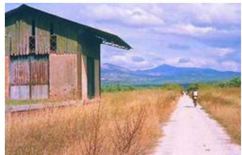
Estación de Vado Jaén y Vía verde del Olivar
