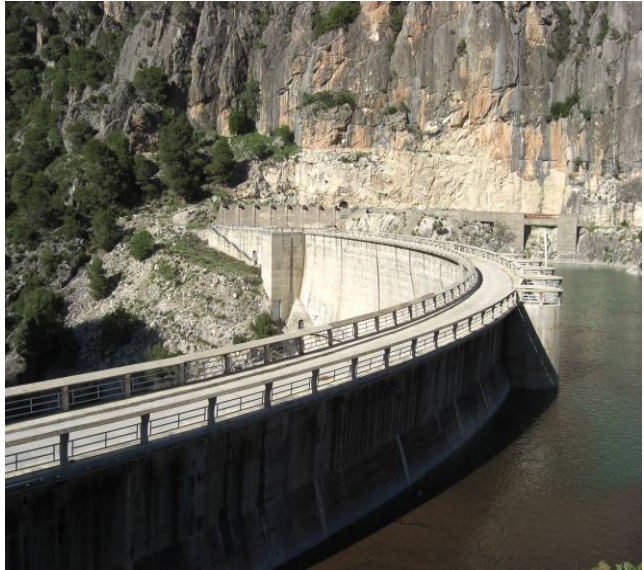
Presa del Embalse del Quebrajano
