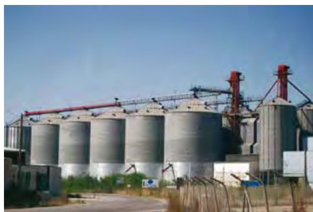
Fig. 9.7. Instalaciones de secado y almacenamiento
