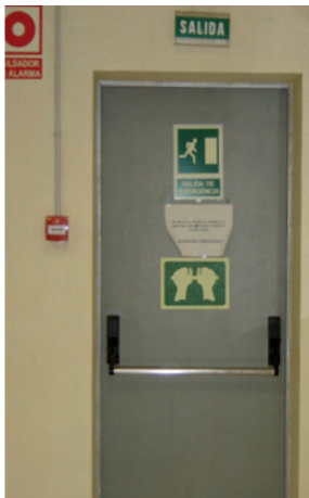
Figura 1. Aplicación de medidas de prevención de riesgos laborales
