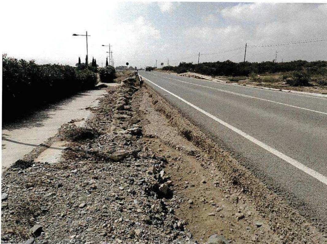
A-1201. Daños en cuneta revestida y eliminación de la berma por arrastre del firme
