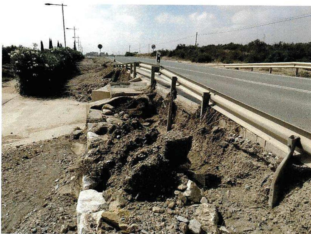
A-1201. Daños en barrera metálica y eliminación de la berma por arrastre del firme
