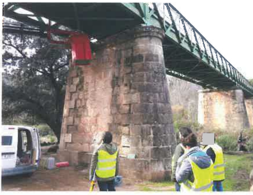
Foto 6: Inspección visual de parte inferior.
