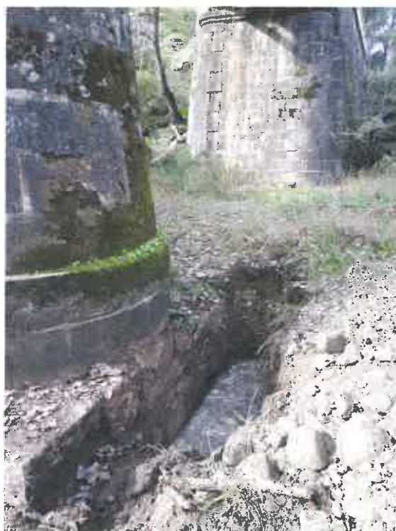
Foto 3: Cata de reconocimiento de cimentación
