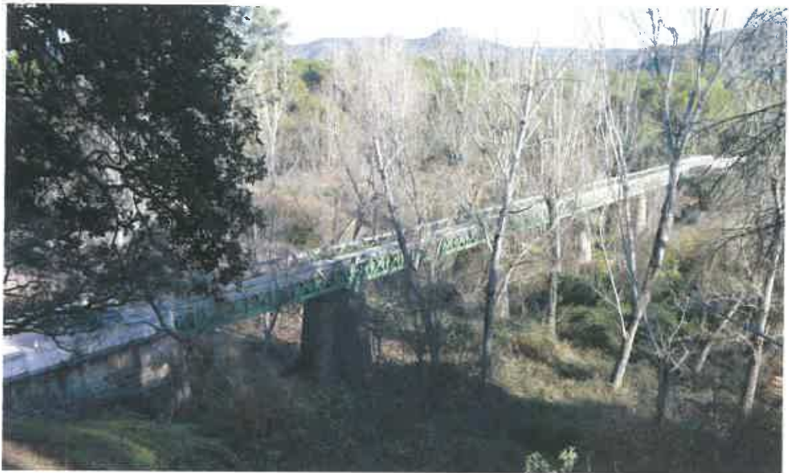
Figura 2. Vista general del puente desde el promontorio situado a la izquierda del E-2 (foto FHECOR)
