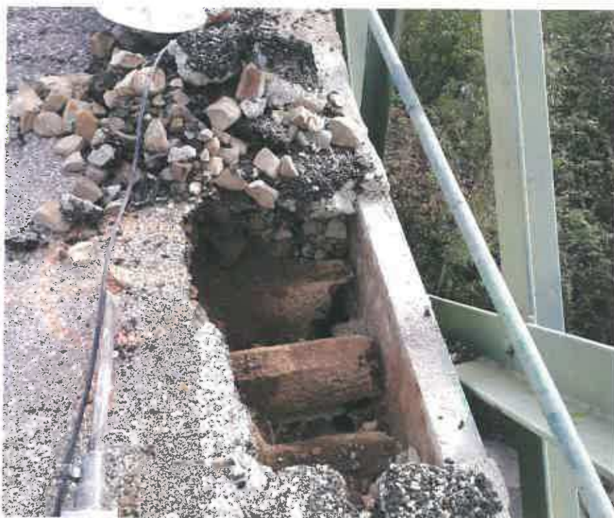
Foto 7 y 8: Calicata realizada en plataforma. Retirada de macadam y visualización de gran deterioro de uniones de perfil omega con larguero
