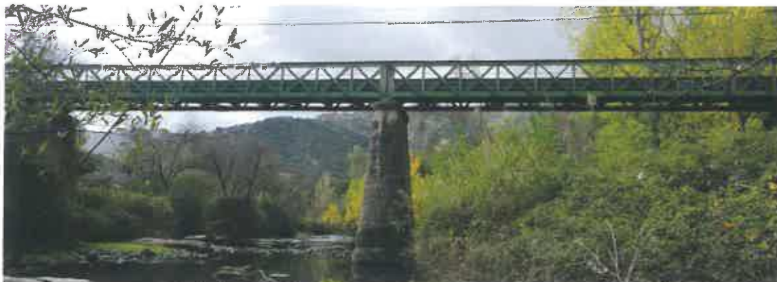
Alzado de P-3 y vanos centrales desde aguas arriba.
