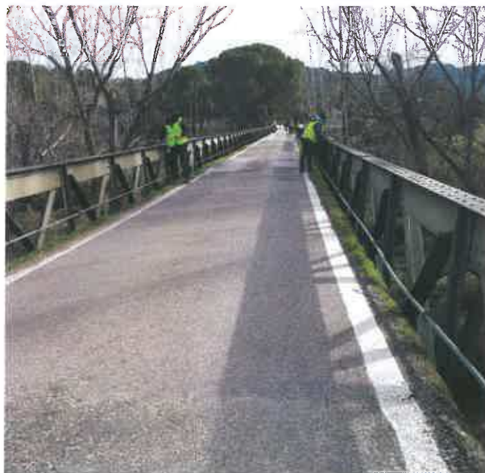
Foto 2: Caracterización geométrica de estructura.
