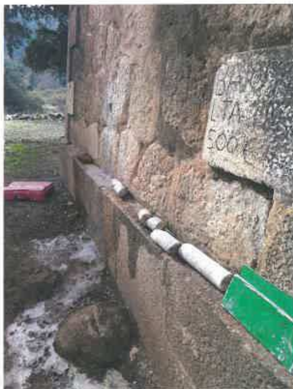
Foto 4: Extracción de testigos de sillería granítica en pila central.
