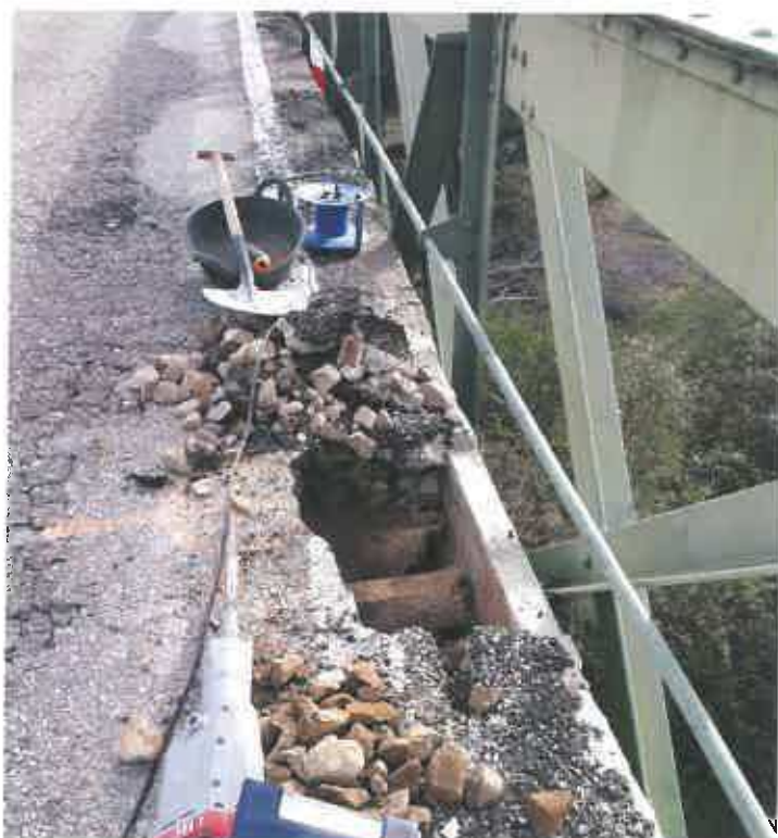
Foto 7 y 8: Calicata realizada en plataforma. Retirada de macadam y visualización de gran deterioro de uniones de perfil omega con larguero
