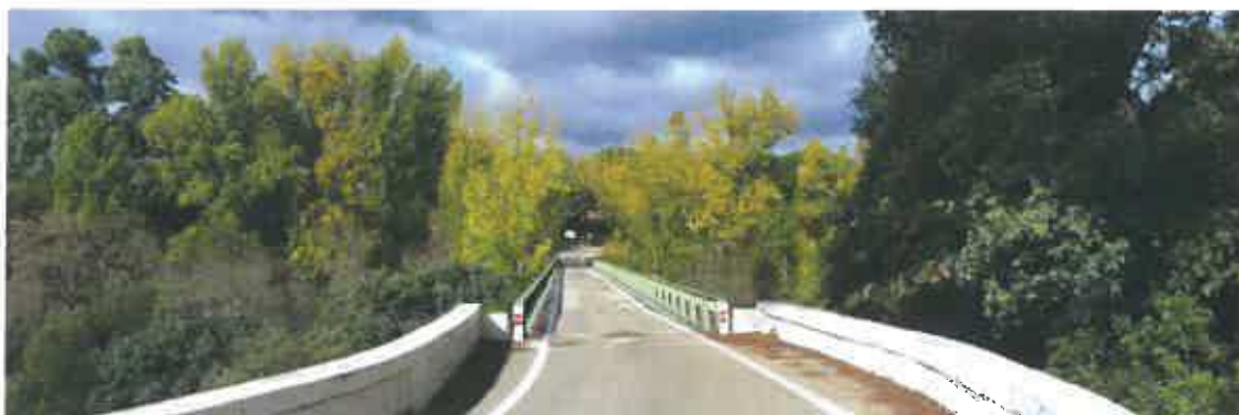
Figura 1. Acceso el puente desde el estribo 1.
