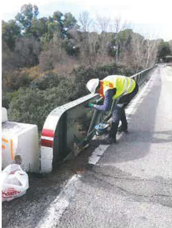
Foto 5: Extracción de testigo de acero en cordón superior de celosía
