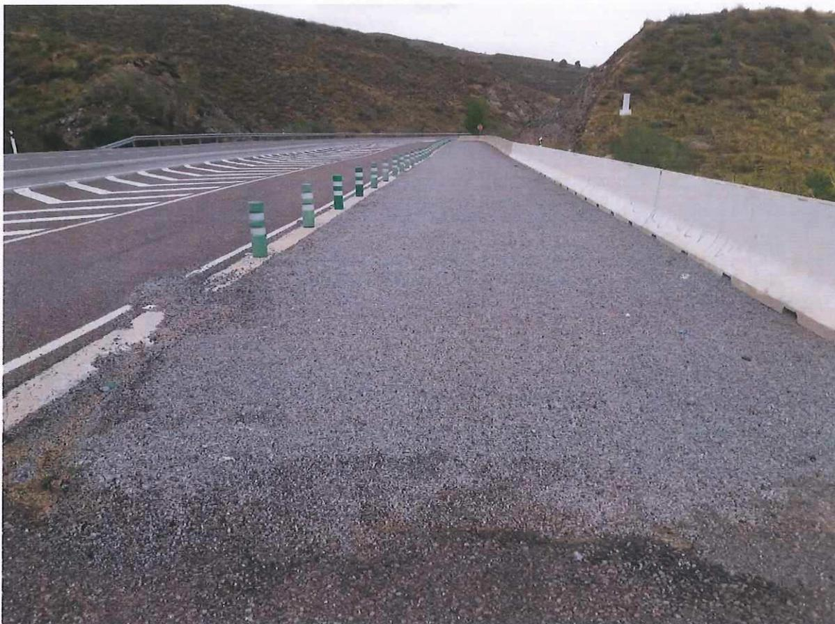
Lecho de frenado con el material prácticamente cementado por arrastre de finos y paso del tiempo
