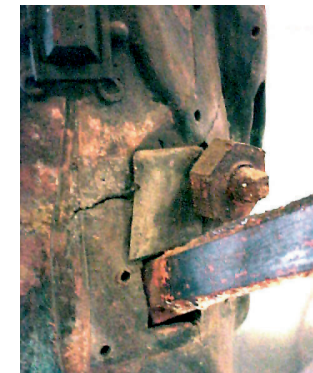
Figura 7.2. Desmontaje de refuerzos internos de hierro,
