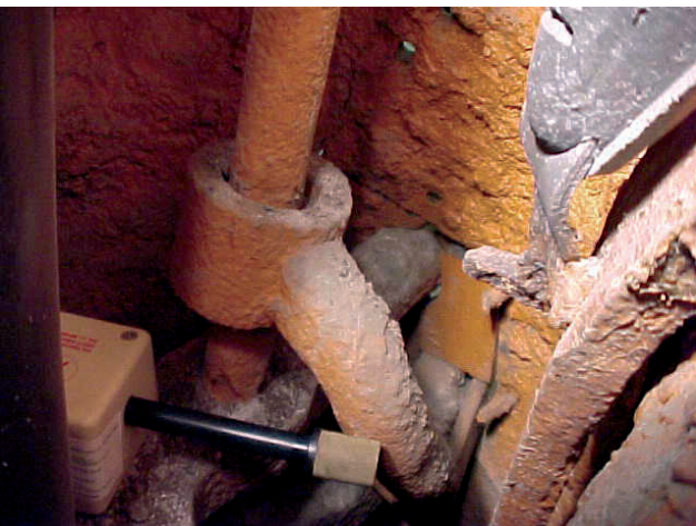
Figura. 5.3. Detalle de unión entre barra de la palma y tirante izquierdo (vista interior del Giraldillo)
