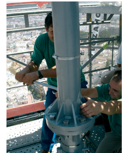
Figura 10.16. Apriete con llave dinamométrica de los tornillos en la unión del carrete al eje de la Torre.
