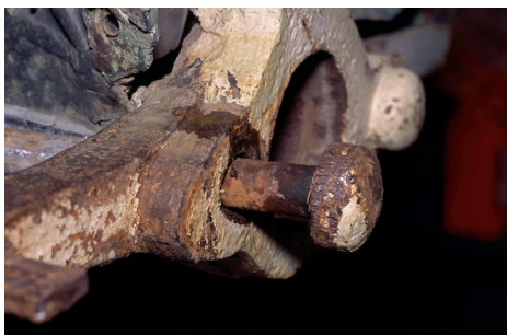
Figura 7.5. Corte de tirante derecho en su parte superior y desvinculación de elementos transversales
