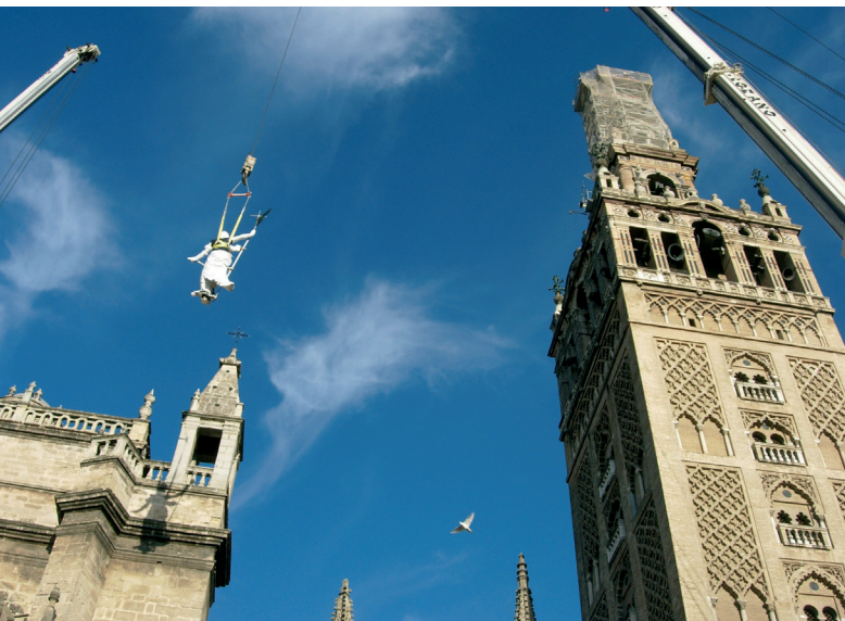
Figura 10.21. Izado del Giraldillo convenientemente protegido. (Foto: Mariano Asuero)
