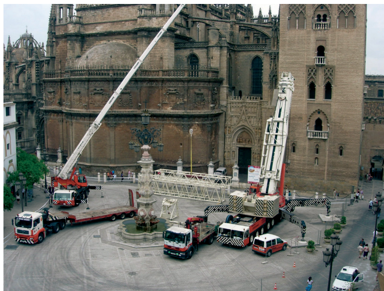
Figura 10.5. Preparativos e instalación de los medios para los trabajos de bajada de la Réplica e izado del Giraldillo.
