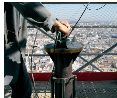
Figura 10.12. (a) (b) Preparación de la brida de apoyo previa a su tratamiento de protección mediante el apropiado esquema de pintura. (a) Mecanizado de la cara superior de la brida del eje de la Torre para mejorar el asiento del carrete y dificultar la entrada de agua o humedad entre ambas piezas. (b) Los restos de pintura y óxidos en los taladros de la brida del eje de la Torre se eliminaron con ayuda de un taladro portátil.
