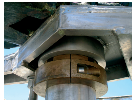
Figura 7.27. Cojinete alojado sobre el travesaño superior de la estructura de 1770 y en la nueva estructura (parcialmente introducido en su alojamiento con la estructura antes de ser montada y visto desde el interior de la escultura con la estructura ya montada)
