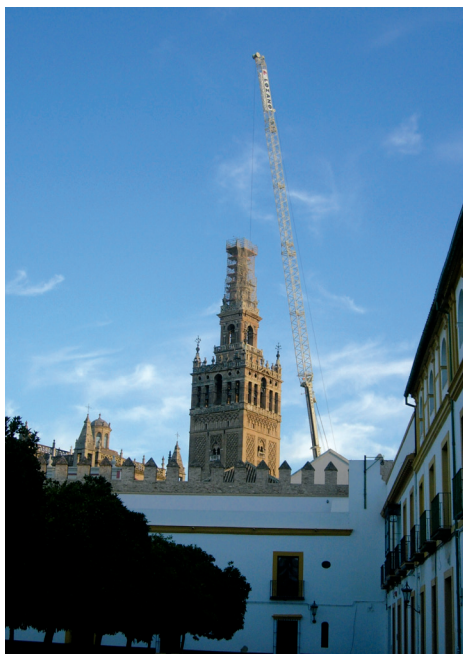
Figura 10.18. Vista general de la instalación del andamio y la grúa utilizada en las operaciones (Foto: Mariano Asuero)
