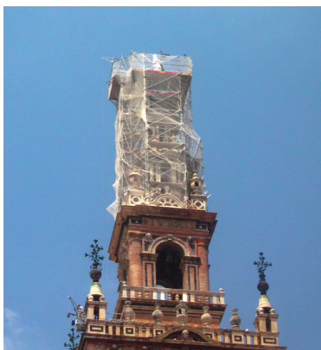
Figura 10.2. Detalle del andamio multidireccional-modular instalado.
