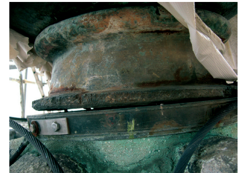
Figura 10.17. Montaje de la tinaja, con ayuda del elevador manual, sobre el eje de la torre y carrete. (a) Detalle del casquillo de bronce sobre el que descansa la bola; (b) colocación de cuñas para su correcta colocación y asiento; (c) centrado del carrete en la abertura superior de la tinaja. (Fotos: Mario Solís)
