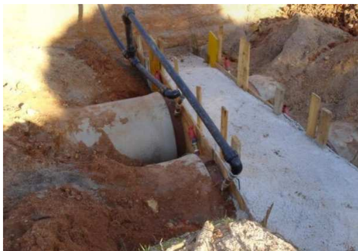
Imagen 1. Obras en curso del Proyecto de Mejora del Fresno.
