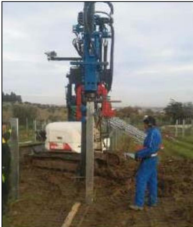
*Esquema de mesas del seguidor, con las estructuras de hinca y ejecución de una hinca de un soporte.*
