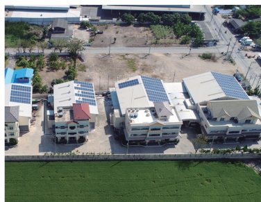
Cubiertas de edificios. Tailandia 90kW
