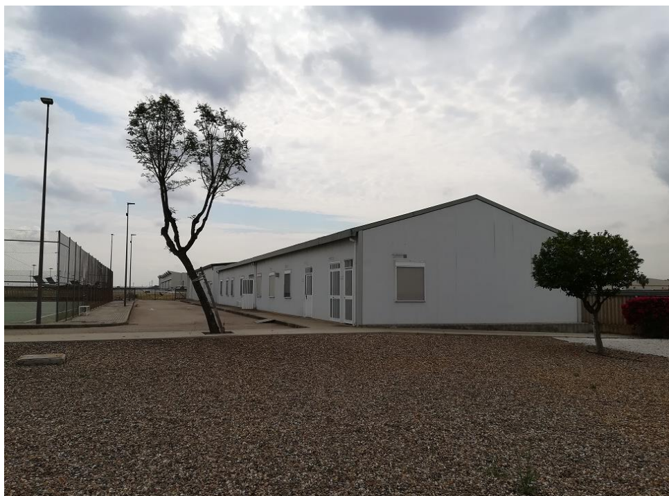
VISTA NOROESTE NAVES MODULARES
