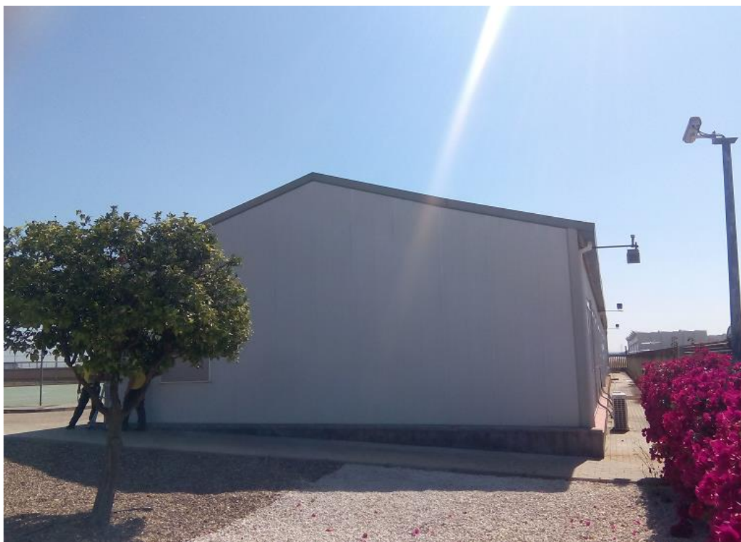
VISTA OESTE NAVES MODULARES
