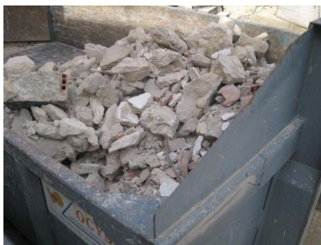
Contenedores de residuos 2
