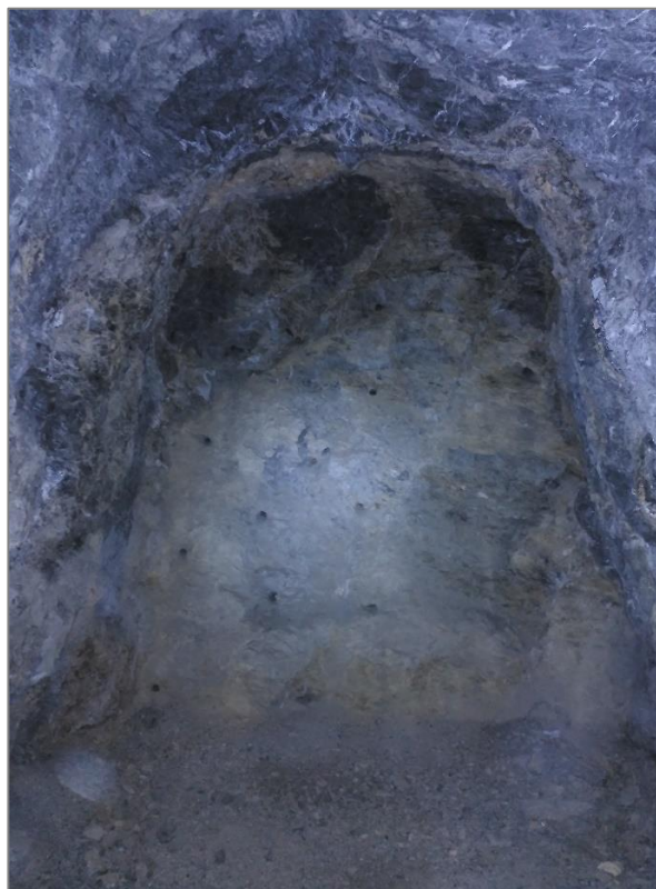
Figura 23. Final de galería a prolongar en Mina Fabiola
