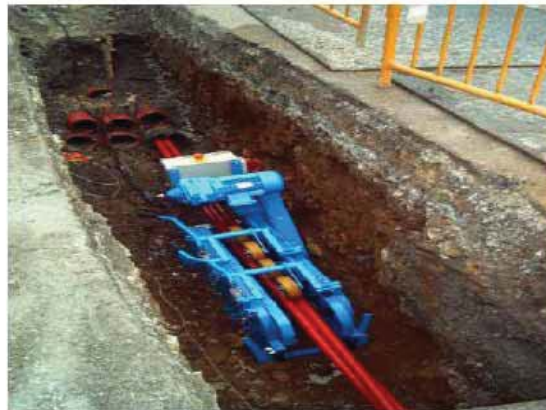
Figura. Máquina de ayuda al tendido
