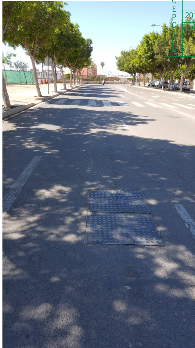
Arqueta de empalme final en calle Isla de Cabrera (altura de calle África)
