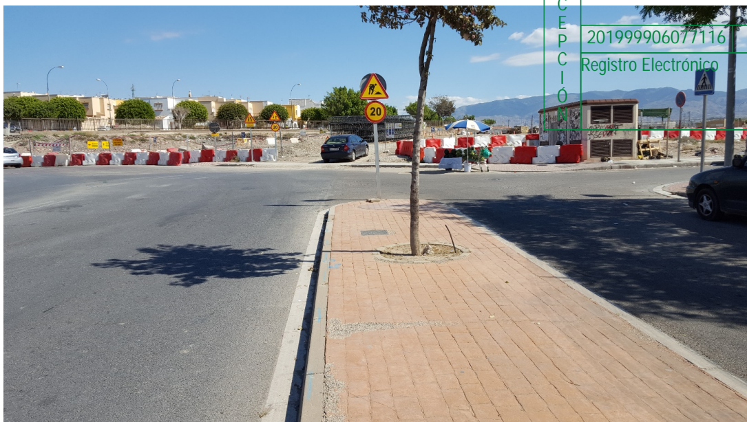
Entrada de canalización en nueva Glorieta de Isla de Dragonera desde Av. Tolerancia (existencia de SSAA)
