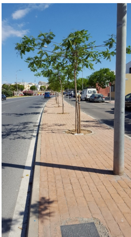
Recorrido canalización existente en Av. Tolerancia (altura de calle Amas de Casa) Zona donde se ubicará la nueva arqueta de empalme
