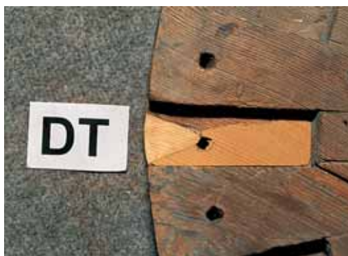
40. Injertos de madera en una de las cajas de alojamiento de los radios en el disco dentado trasero
