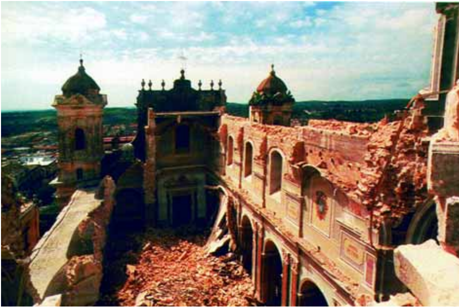
En la Catedral de Noto, el colapso de un pilar afectó a toda la nave y parte de la cúpula debido al efecto de arrastre que ocasionó un “veintesisiglero” forjado de hormigón armado soporte de una siglo “veintesisiglera” cubierta plana. Fuente: DE BENEDICTIS, ROBERTO, TRINGALI, SALVATORE: LaRicostruzione della Cattedrale di Noto, Noto: L.C.T. Edizioni, 2000
