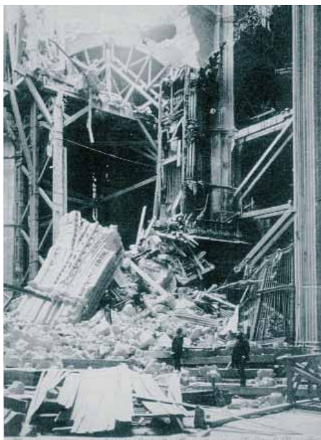
Colapso dramático pero local debido al fallo de pilar del ángulo sur-oeste del crucero de la Catedral de Sevilla en 1888. Fuente: El espíritu de las antiguas fábricas . Sevilla: FIDAS, 1999
