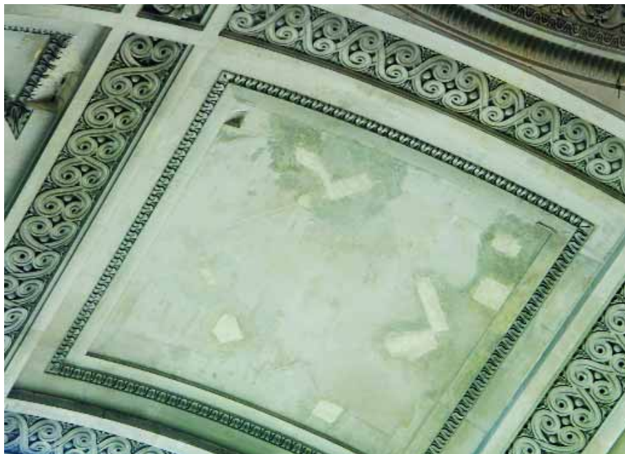
Desperfectos graves debidos a la oxidación de las armaduras que sostienen los sillares y dovelas en el interior de de la Iglesia de Santa Genoveva de París. Foto: Jose Luis González Moreno-Navarro
