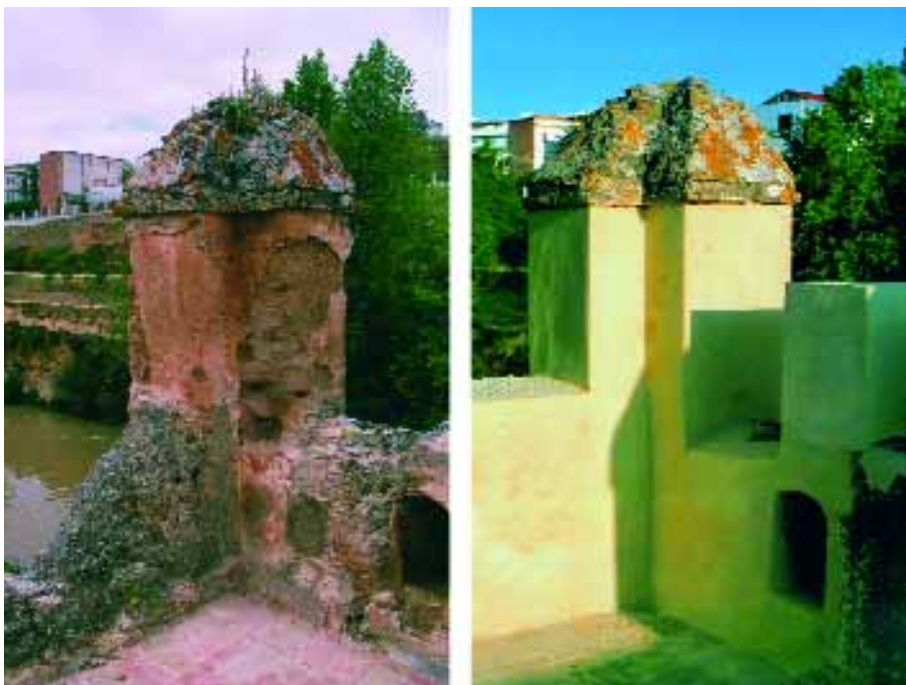
Molino del Algarrobo: restauración del merlonado. Foto: Enrique Luis Domínguez Berenjeno y Lara Cervera Pozo
