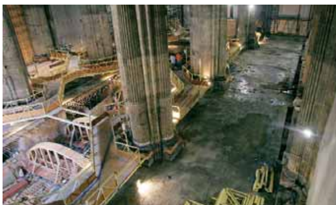
Excavación del subsuelo. Pasarelas peatonales que permitan la visita de la obra, soportadas por estructuras metálicas. Cripta obtenida con una losa de hormigón armado, reforzada mediante arcos carpaneles que siguen la pauta de la matriz de las bóvedas originales. Foto: Estudio Fernando Mendoza Castells
