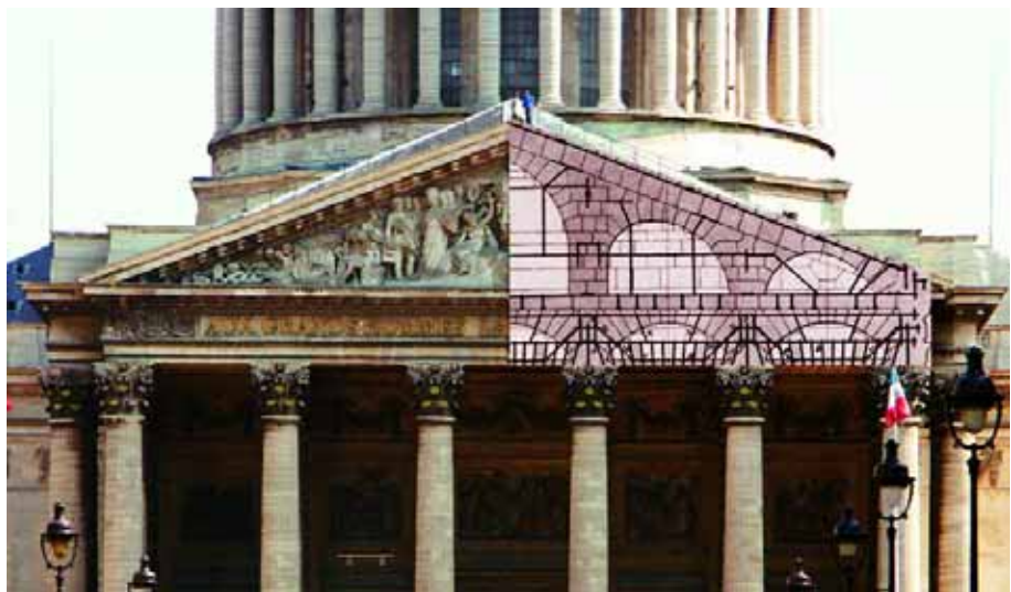
El pronaos de la Iglesia de Santa Genoveva de París es uno de los primeros ejemplos de sillería armada al servicio de unas formas arquitectónicas fuera de escala. Foto: José Luis González Moreno-Navarro con un detalle extraído de RONDELET, Jean. L'art de bâtir . París, 1802-1818
