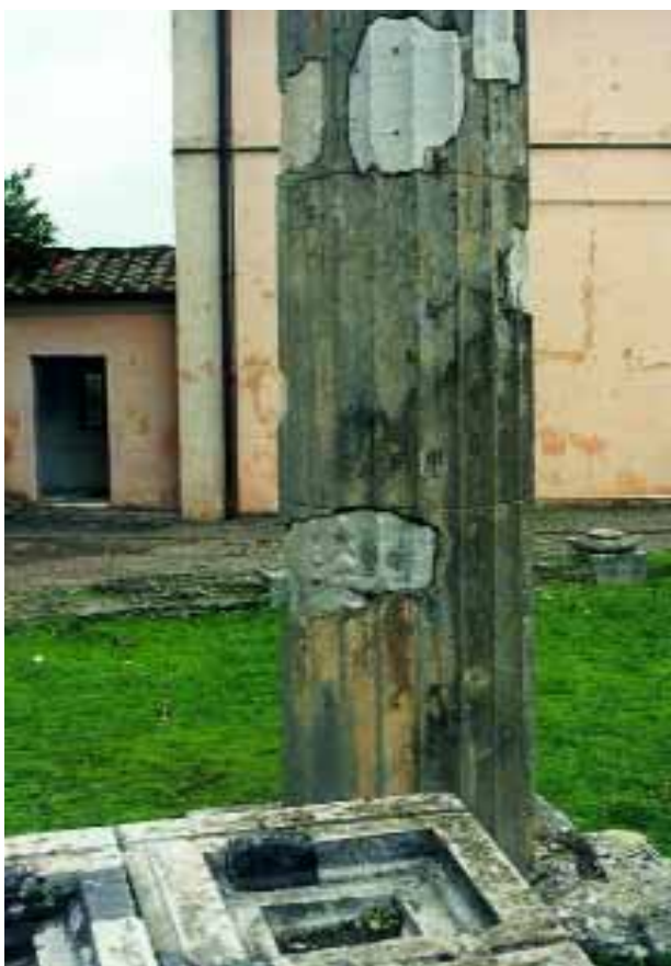
Detalle de uno de los fustes de las columnas del templo de Venus Cnidia en Villa Adriana, con la actuación de anastylis mediante el empleo de cemento Pórtland en fase de sustitución. Foto: Isabel Bestué Cardiel
