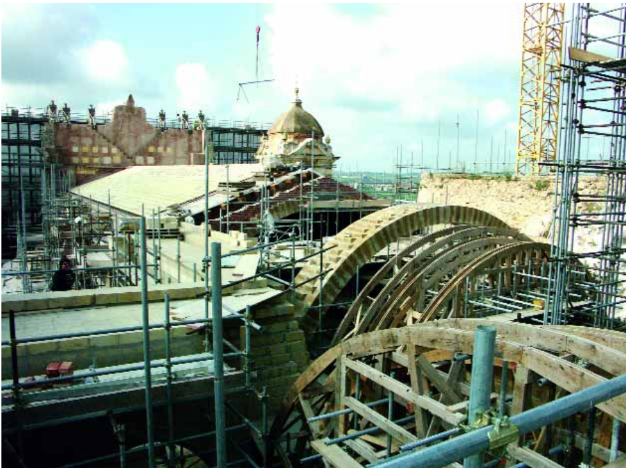
En la reconstrucción de la Catedral de Noto se recuperó en sillería (sin armar, obviamente) todo el conjunto de pilares y arcos que dan soporte a la recuperada cubierta a dos aguas y a la bóveda de cañón seguido encamonada del interior. Foto: José Luis González Moreno-Navarro
