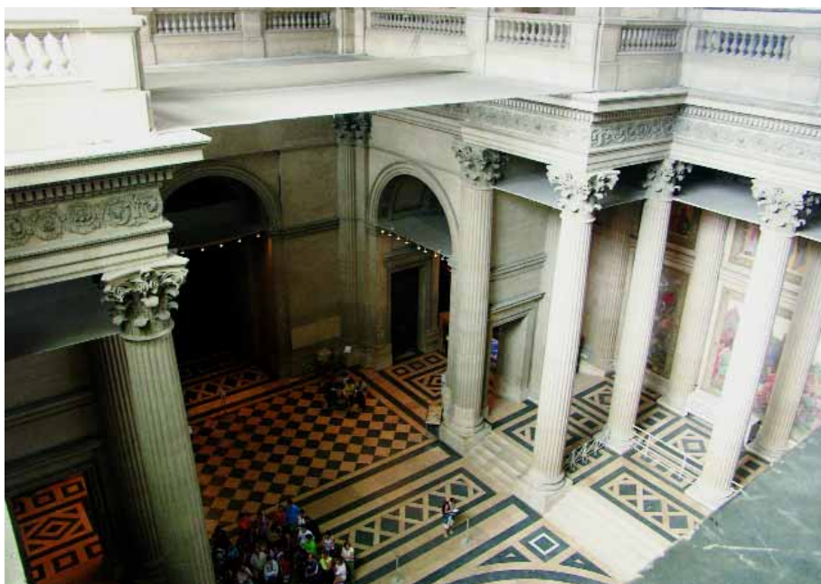
En la actualidad en la Iglesia de Santa Genoveva de París se han reparado los desperfectos anteriores pero no se ha podido detener el proceso de rotura de la piedra lo cual obliga a limitar la zona visitable y proteger ésta con redes. Foto: José Luis González Moreno-Navarro
